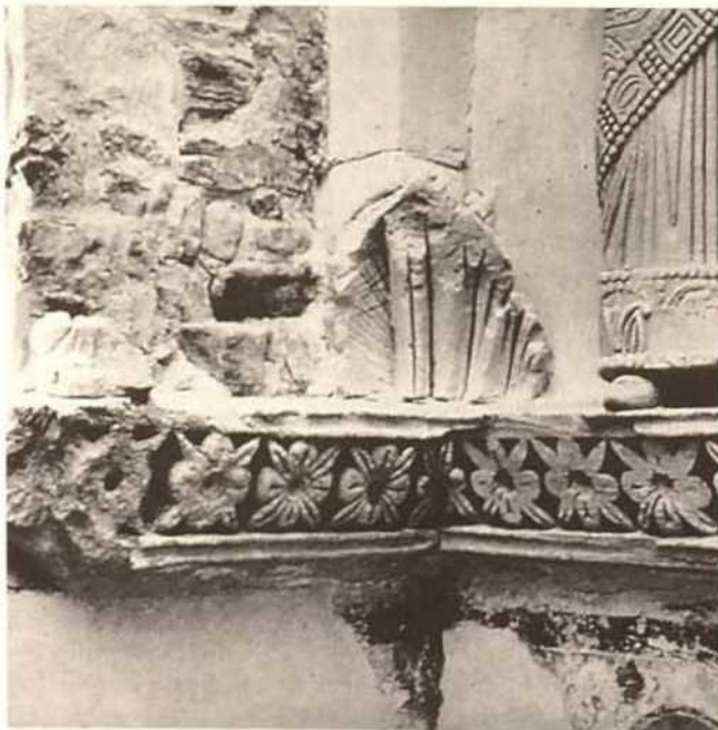
Abb. 34. Cividale, S. Maria in Valle (sog. Tempietto), Westwand, Detail der Südwestecke mit mehrschichtigem Stuckaufbau und Einritzungen auf der untersten Ebene zur besseren Haftung der folgenden Schichten.
