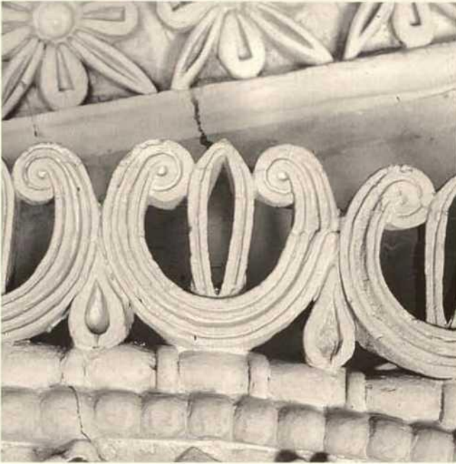
Abb. 33. Cividale, S. Maria in Valle (sog. Tempietto), Westwand, Detail der Lünettenrahmung mit vorgefertigten und mit dünnflüssigem Mörtel angeklebten Zierelementen.
