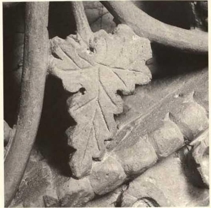
Abb. 32. Cividale, S. Maria in Valle (sog. Tempietto), Westwand, Detail der Lünettenrahmung mit Arbeitsspuren des Messers in der noch feuchten Stuckmasse.
