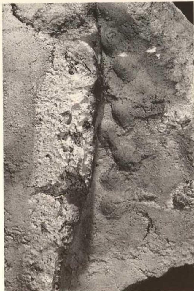
Abb. 135. Hildesheim, St. Michael, mehrschichtig angetragenes Stuckfragment mit Fingerabdrücken des Stuckateurs.
