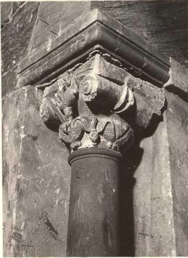
Abb. 158a. Bamberg, Dom, Nische am westlichen Abschluß der Ostkrypta, nördliches Kapitell.
