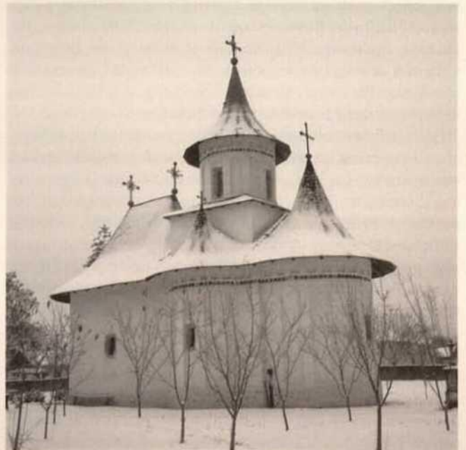
Heiligkreuzkirche in Pătrăuți, Ansicht gegen Süden / Eglise de Sainte-Croix à Pătrăuți, vue vers le sud
