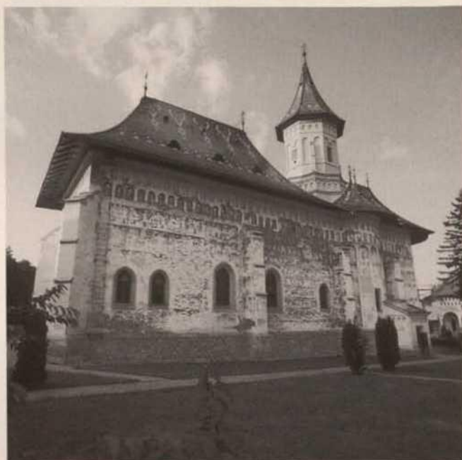
St. Georgskirche des Klosters zum hl. Johann dem Neuen in Suceava, Ansicht gegen Süden / Eglise Saint-Georges du monastère de Saint-Jean-le-Nouveau à Suceava, vue vers le sud
