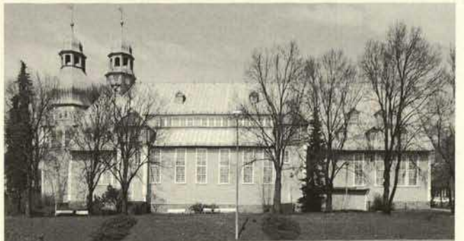
Abb. 6. Clausthal-Zellerfeld. Die Marktkirche zum heiligen Geist wurde 1642 von den Clausthaler Bergleuten in Holzfachwerkbauweise errichtet.
