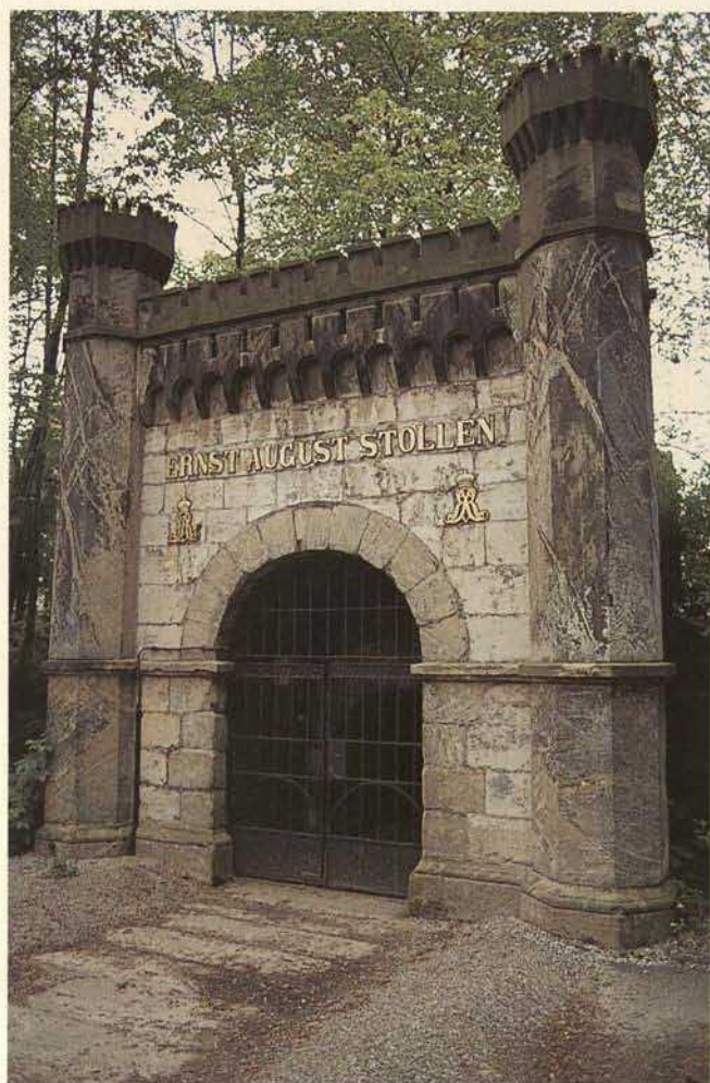
Abb. 11. Gittelde. Das als architektonisch anspruchsvolles Portalbauwerk gestaltete sog. Mundloch des ca. 26km langen Ernst-August-Stollens wurde 1864 errichtet.
