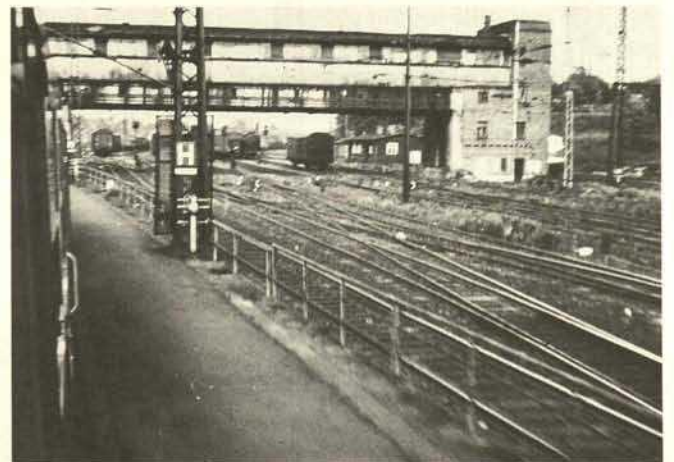
Abb. 4. Chemnitz-Hilbersdorf, elektromechanisches Brückenstellwerk (Zustand 1985).
