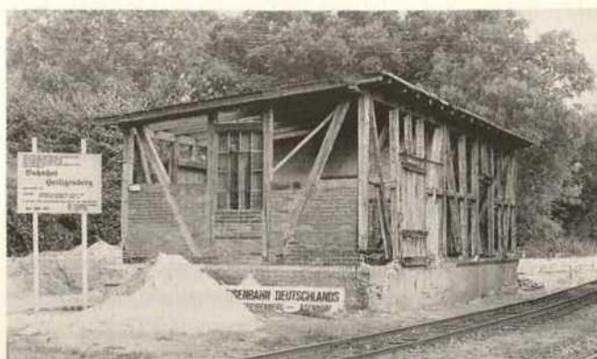
Abb. 23. Heiligenberg, Güterschuppen der Kleinbahn Hoya-Syke-Asendorf: Fachwerkbau mit Pultdach und Kriechkeller (Zustand 1989, während der Erneuerungsmaßnahmen).
