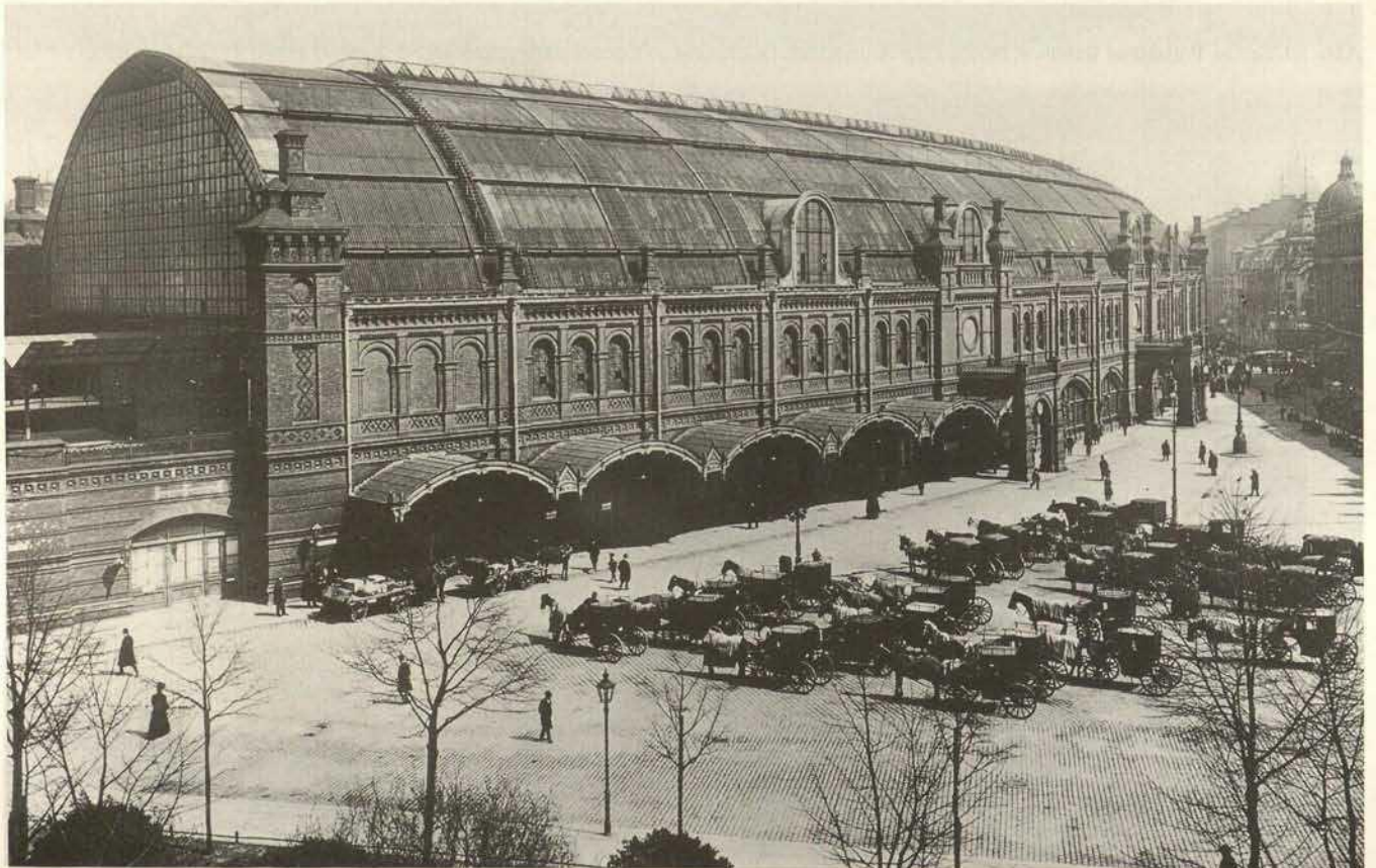
Abb. 52. Berlin-Mitte, Stadtbahn-Bahnhof „Friedrichstraße“, nach Entwurf Johannes Vollmers 1882 fertiggestellt (um 1900).
