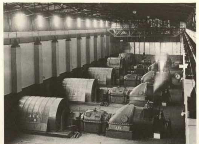
Abb. 76. Muldenstein bei Bitterfeld, Bahnkraftwerk von 1911, Blick in die Turbinenhalle (1940).
