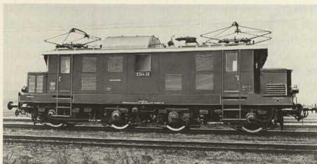
Abb. 71. Versuchslokomotive für den 50 Hz-Betrieb auf der Höllentalbahn im Schwarzwald (1947).
