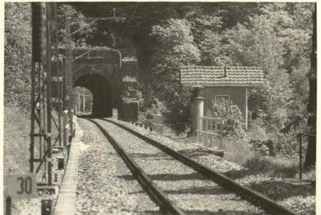
Abb. 95. Gotthardlinie am Vierwaldstättersee, Einspur-Streckenabschnitt von 1882 mit Tunnelportal, Streckenwärterunterstand, Lätwerk und Fahrleitungsmasten (z. T. aus der Zeit der Elektrifizierung, 1919).
