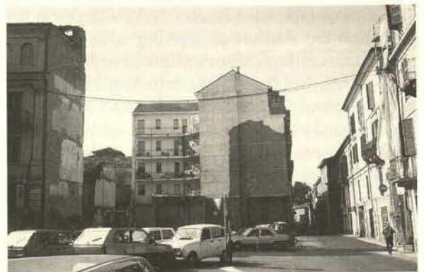
7 Nizza Monferrato, Piazza, Abbruch an der Nordwestecke. Reversibel allenfalls im städtebaulichen Gesamtbild
