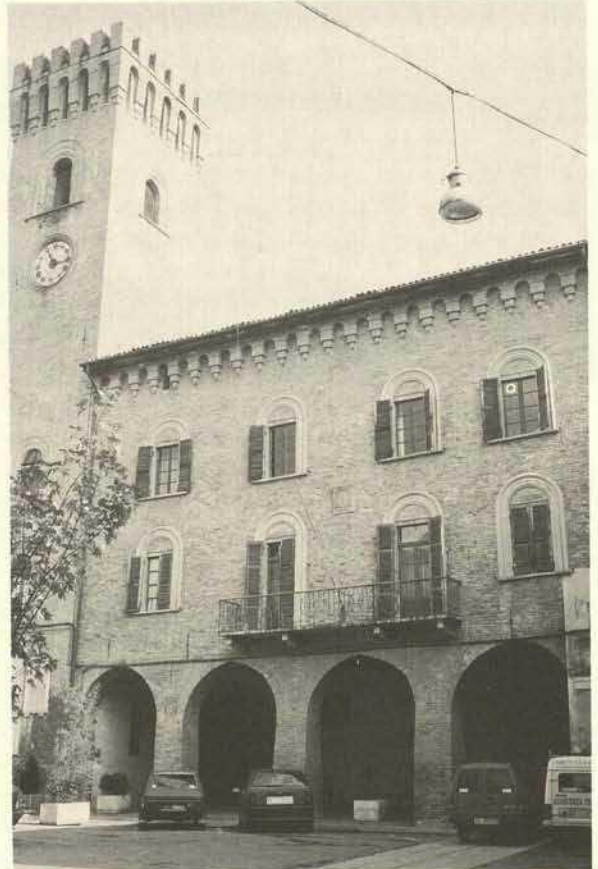
5 Nizza Monferrato, Rathaus, Fassade zur Piazza. Beispiel für weitgehend ausgetauschte Schmuck- und Ausbausubstanz
