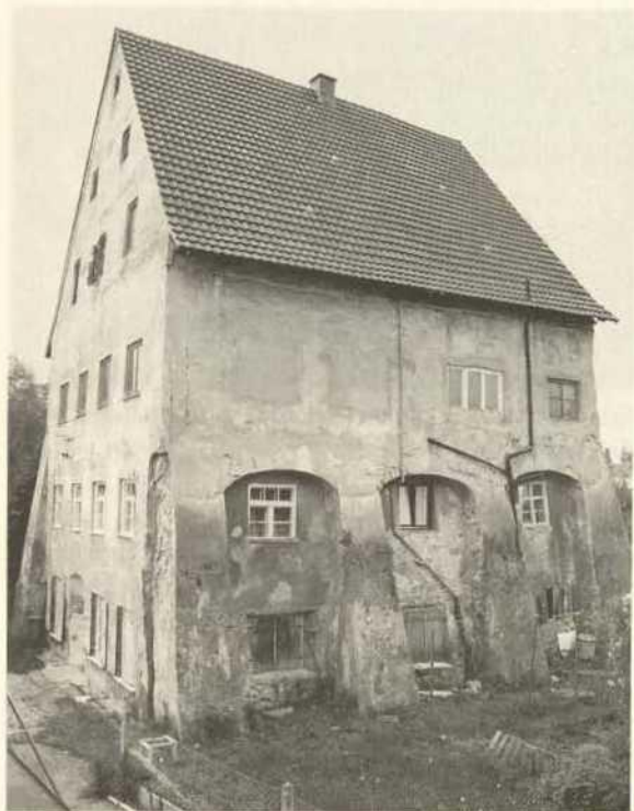
12 Krumbach, Hürbener Schlößchen, Ansicht von Südosten, Zustand 1978 vor der Maßnahme
