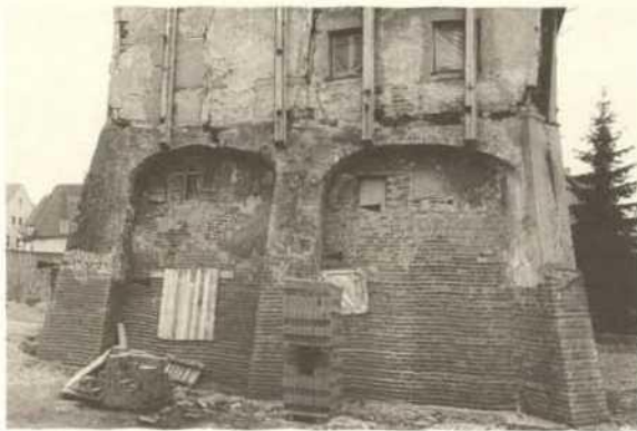
19 Krumbach, Hürbener Schloßchen, Unterbau, Nordseite, Beschränkung der Erneuerung auf Teilbereiche unter Berücksichtigung denkmalpflegerischer Anforderungen. Linie der Auswechslung im Foto markiert (1982).
