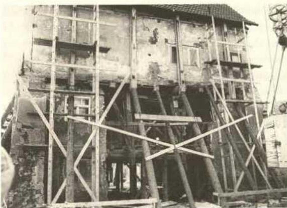
16 Krumbach, Hürbener Schließchen, Abbruchtunnel zur konstruktiven Sicherung mit freigelegtem Holzwerk: eine Maßnahme ohne Diskussion der denkmalpflegerisch günstigeren Alternativen (1981).
