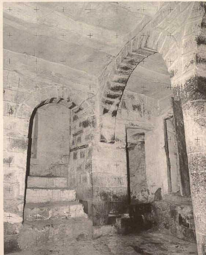
Abb. 15. Samsarat al-Mansurah; Erdgeschoß, zentrale Halle, nördliche Bogenstellung und Anfang des Treppenhauses; 1988 Fig. 15. Samsarat al-Mansurah; central hall on the 1 st floor, north arch and the beginning of the staircase; 1988
