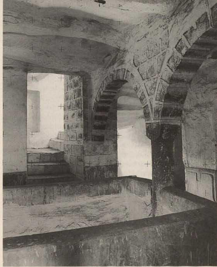
Abb. 13. Samsarat al-Mansurah; 2. Obergeschoß, Halle und Treppenhaus; 1988 Fig. 13. Samsarat al-Mansurah; 3 rd floor, hall and staircase; 1988
