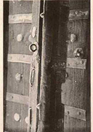
und wiederzuverwendenden Türblättern ausgeführt. Trotz intensiver Anleitung und Kontrolle kamen immer wieder Handmaschinen aus Gründen der Zeitersparnis und aus einem noch vorhandenen gewissen Mangel an Feingefühl im Umgang mit dem Material zur Anwendung. Trennscheibenschleifspuren sind so an manchen Stellen, trotz Nacharbeiten von Hand, sichtbar geblieben.
