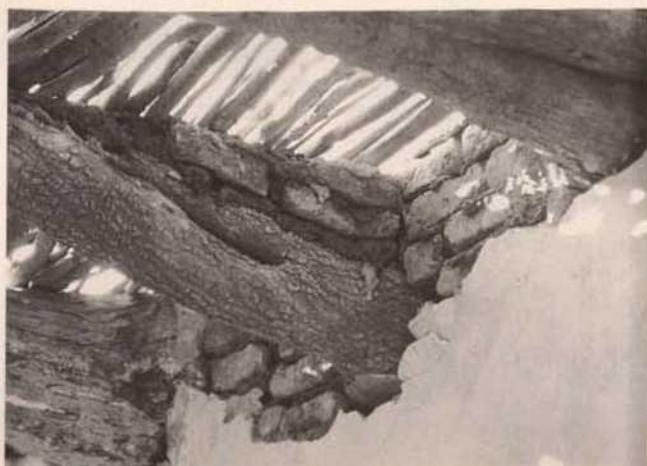
Abb. 27. Rohdeckenaufbau: Rundhölzer, Knüppel, Lehm, Trockenschüttung
