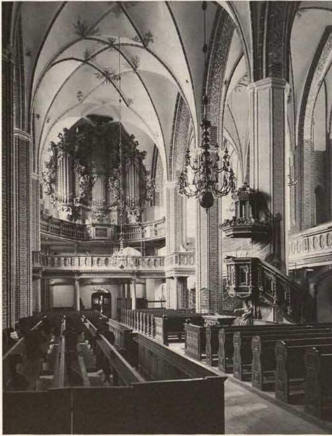
Abb. 5. Brandenburg, Katharinenkirche. Kirchenschiff nach der Restaurierung der Gewölbe (1991).
