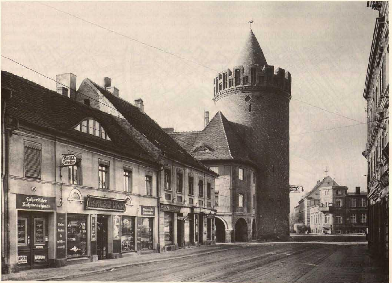
Abb. 11. Brandenburg, Steinstraße mit Steintorturm (Zustand 1928).
