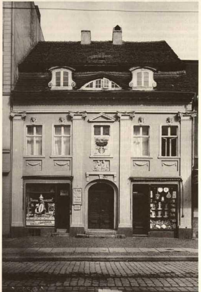
Abb. 12. Brandenburg, Steinstraße 21 (Zustand 1928).
