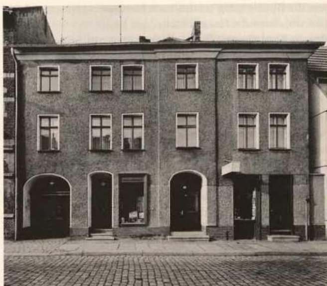
Abb. 13. Brandenburg, Molkenmarkt 24, Fassade (Zustand 1992).
