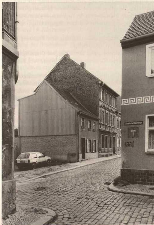
Abb. 29 a. Brandenburg, Baulücke Fischerstraße 20.
