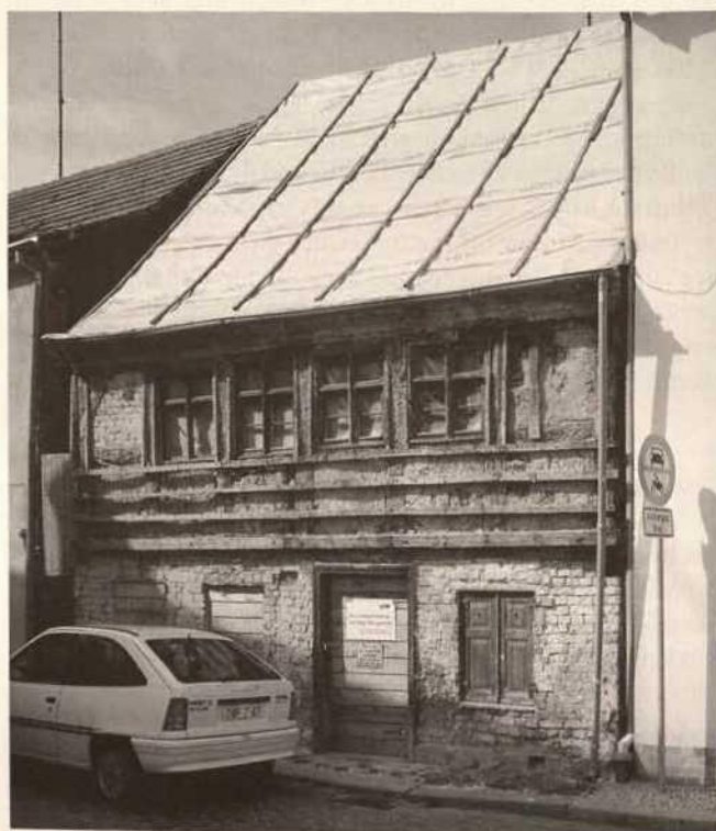
Abb. 24. Brandenburg, Wollenweberstr. 24, nach Dachsicherung mit Folie.
