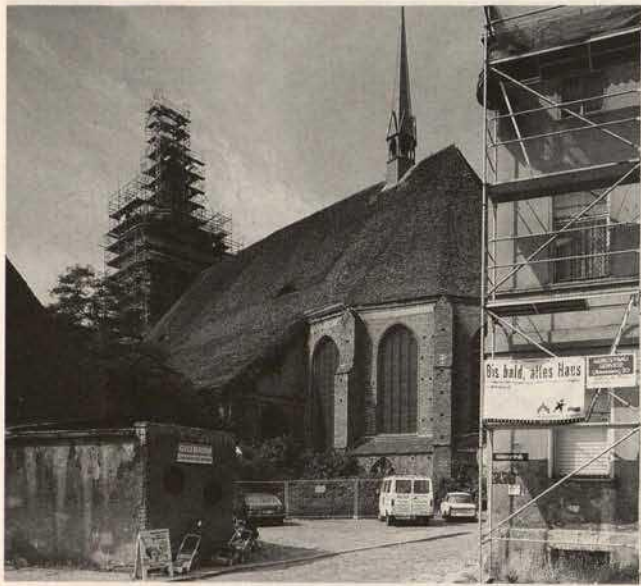
Abb. 27. Brandenburg, St. Gotthard-Kirche, während der Turminstandsetzung (1991).
