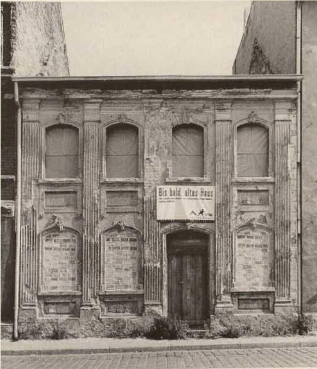
Abb. 25. Brandenburg, Fischerstraße 17, nach Sicherung durch Ausbau und Einlagerung der barocken Fenster und der Haustüre (vgl. Abb. 1 und 58).
