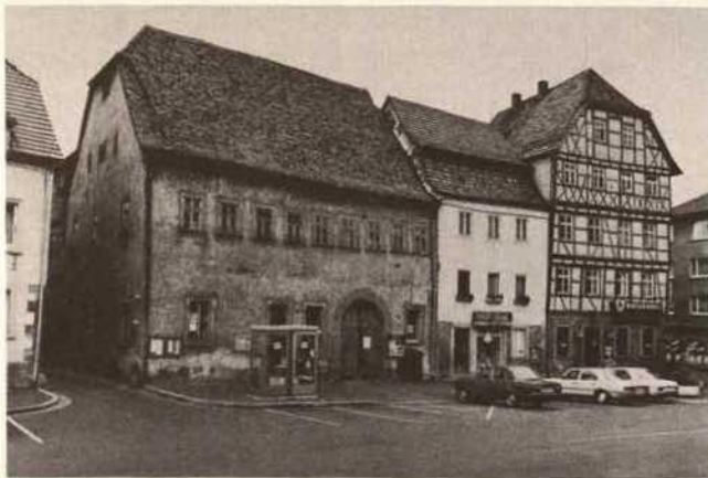
Abb. 51. Münsterstadt, Rathausblock, Marktplatzansicht der Fassaden (vor der Sanierung).
