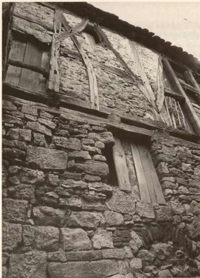
Abb. 49. Münsterstadt, Finstere Gasse, Detail Fachwerk.
