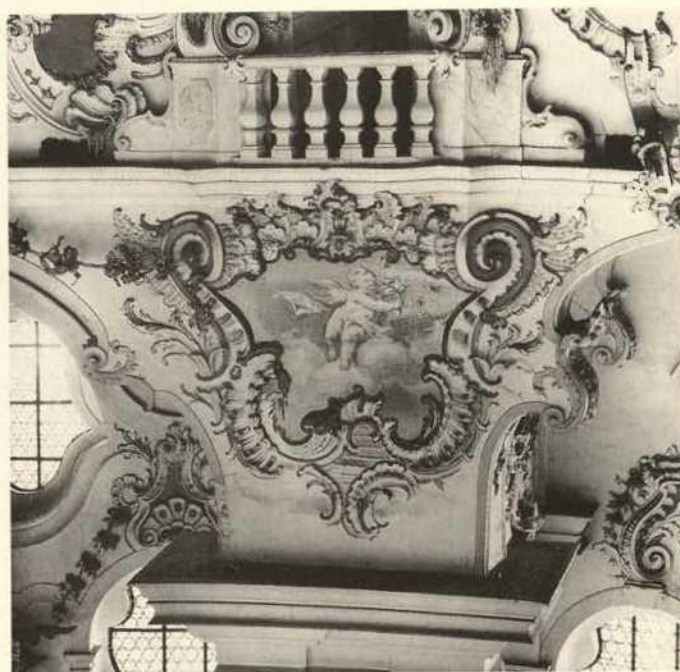
Abb. 1, 2. Wieskirche, Stuckrahmen der Seligkeitskartuschen mit den für diese Bereiche typischen Putz- und Stuckschäden (1986)
