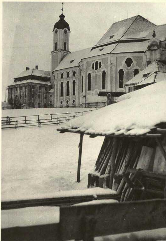
Abb. 18. Ansicht von Nordwesten, 1935, mit Gerüst für die Dachrinnenenerneuerung am Priesterhaus
