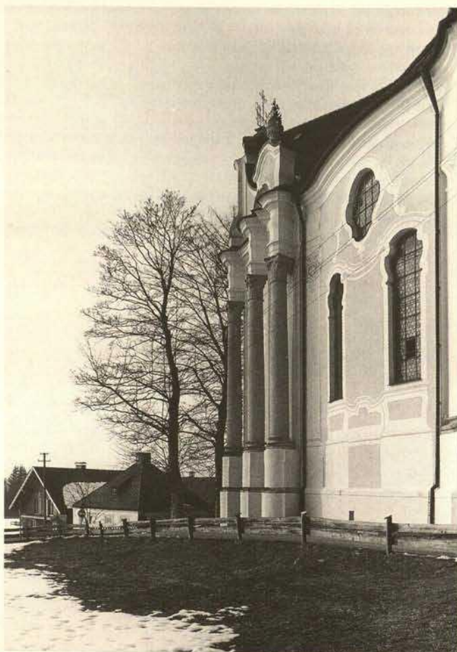
Abb. 3. Ansicht von Südosten, 1984 Fig. 3. View from the southeast, 1984
