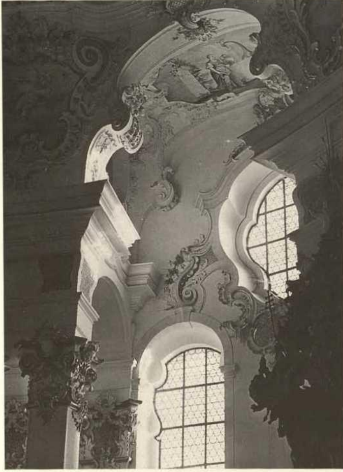
Abb. 7. Langhauswand, Blick auf die Fensterlaibungen Fig. 7. Outer wall of the main space, view into the window reveals
