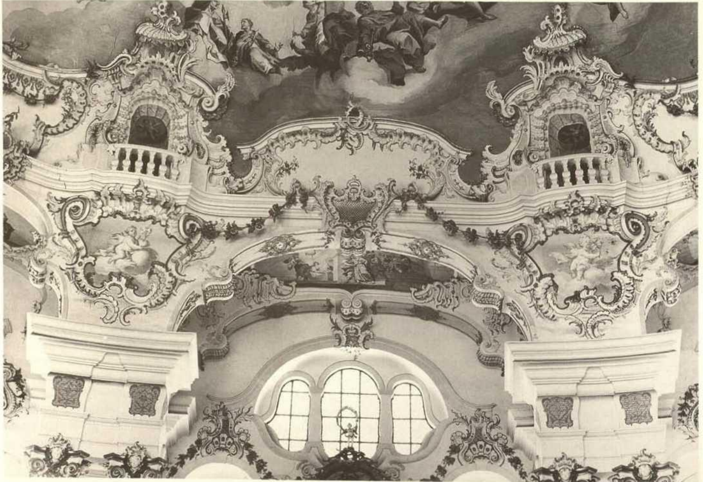
Abb. 10. Langhaus, Übergangsbereich zur Decke / Fig. 10. Nave, transitional zone below the ceiling
