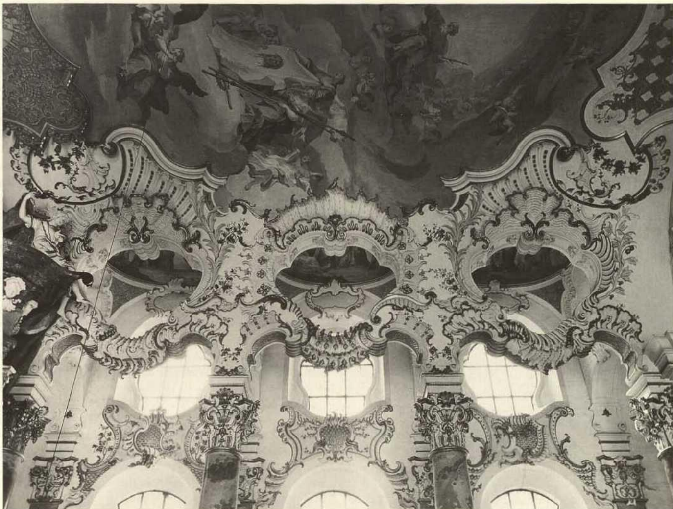
Abb. 1. Wieskirche, Chorsüdseite, Übergangsbereich zur Decke / Fig. 1. Die Wies, south side of the choir, transition zone below the ceiling
