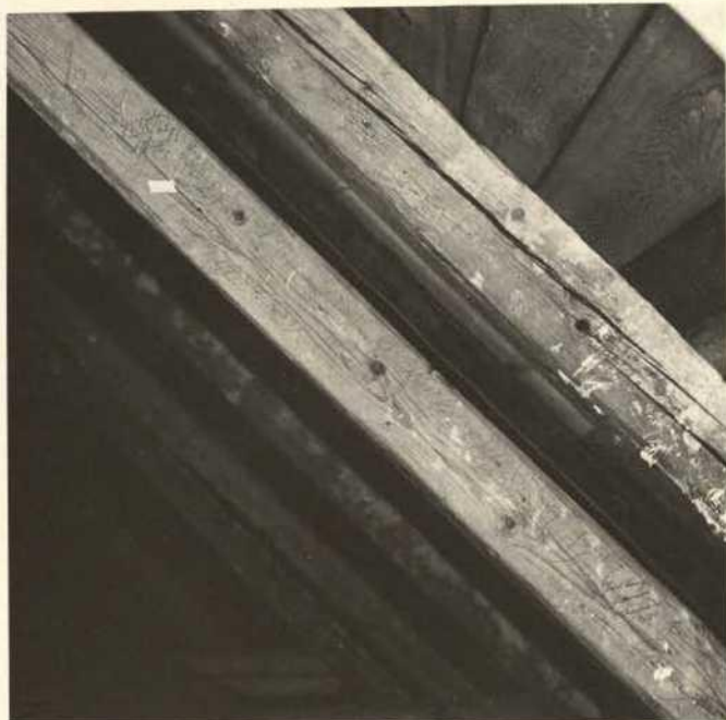
Abb. 8. Rötelschrift: «Josef Mang Zimmergesell zu Schongau» an der südlichen Strebe des Hängewerks III
