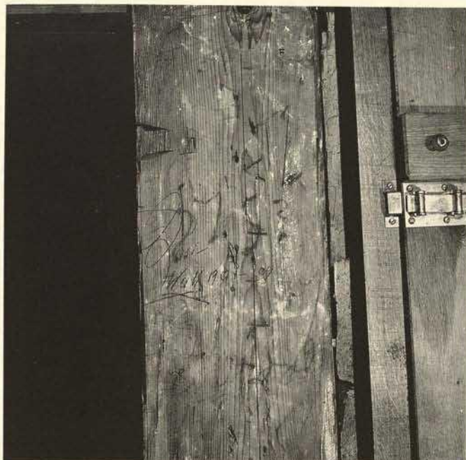
Abb. 10. Kohleinschrift: «1753 J Mang» an einer Stütze der südlichen Fachwerkwand
