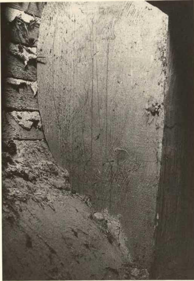
Abb. 11. Unterkonstruktion der Kartusche f; an das Fachwerk genageltes, ausgeschnittenes Brett mit Putzträger; auf dem Brett Rötelskizze (vgl. Abb. 12)
