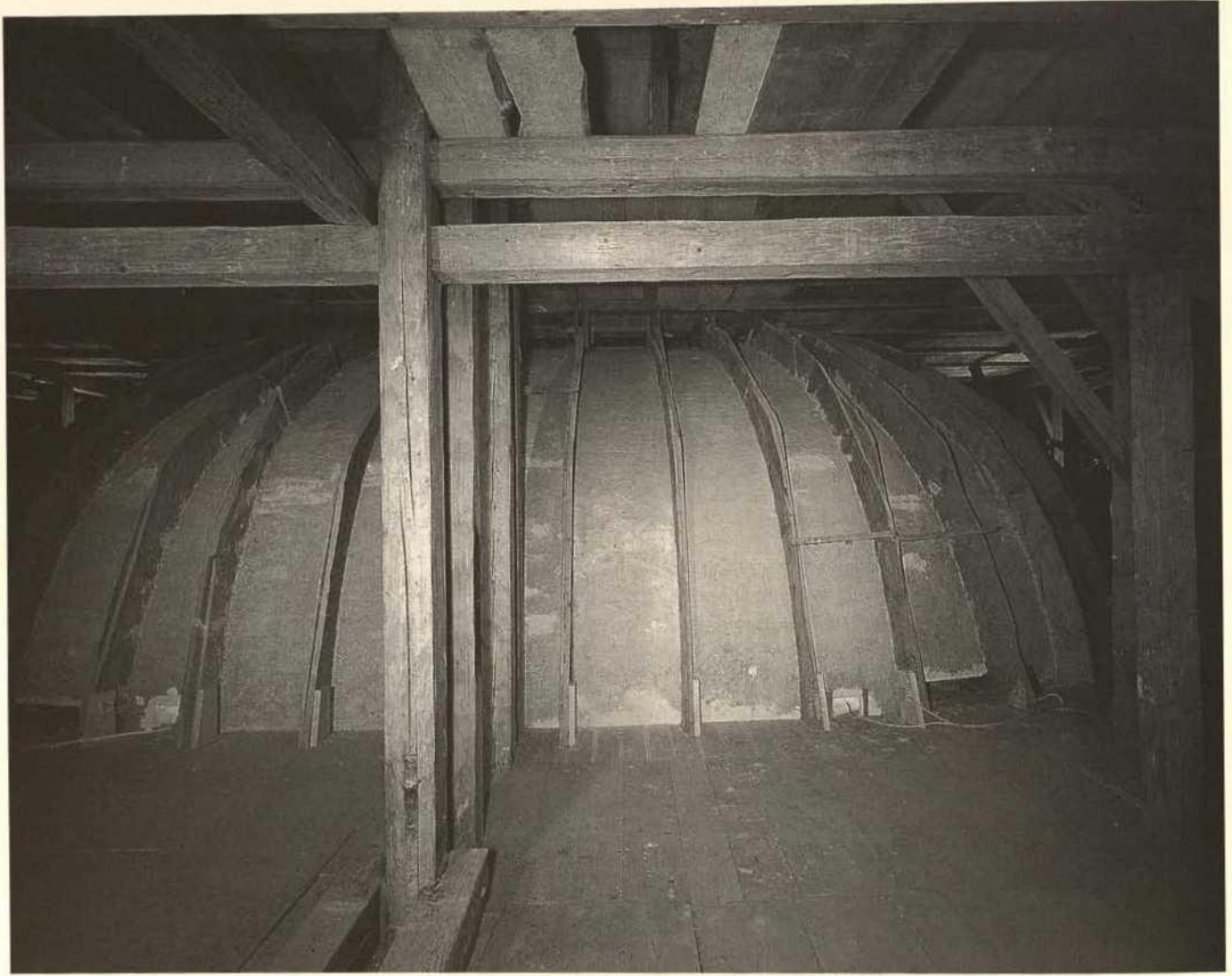
Abb. 14. Außenseite der Kuppelschale, Zone B / Fig. 14. Exterior of the dome shell, zone B
