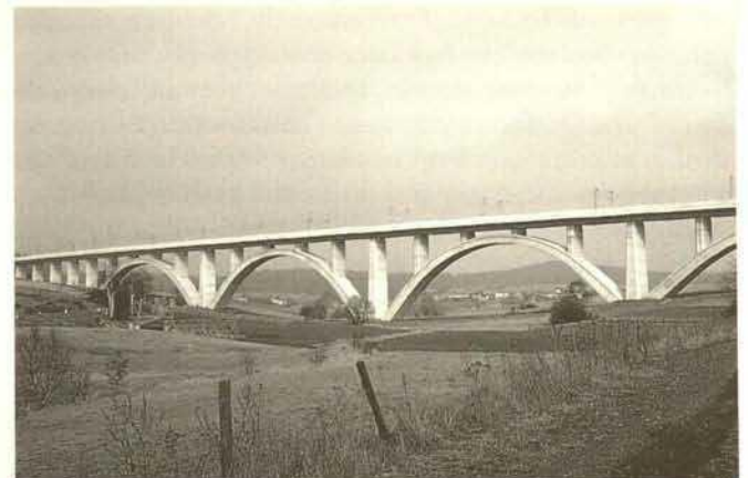
Abb. 3. Wälsbach-Talbrücke, ein gelungenes Beispiel für eine Großbrücke auf der Neubaustrecke Hannover-Würzburg
