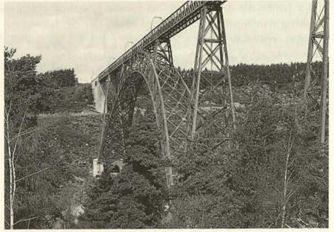
Abb. 2. Pont du Garabit, Eisenbahnviadukt nach einem Plan von Eiffel, 1880-94
