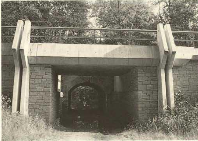
Abb. 1. Wegen einer Gleisfelderweiterung wurde neben einer bestehenden Gewölbekonstruktion eine neue Brücke gebaut, die wie ein Bilderrahmen den Blick auf das alte Bauwerk inszeniert.
