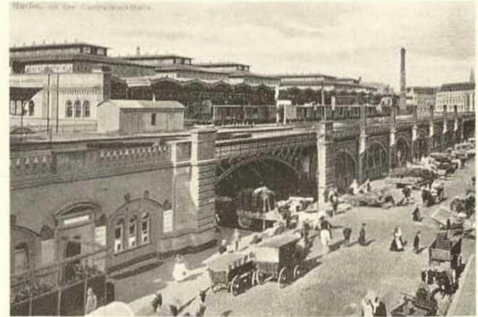
Abb. 2. Berlin, Stadtbahnbögen an der Dirksenstraße, im Hintergrund die Zentralmarkthalle am Alexanderplatz, Aufnahme kurz nach 1900
