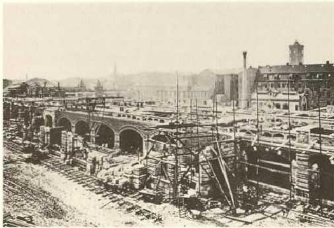
Abb. 1. Berlin, Stadtbahnbau am Alexanderplatz und am Königsgraben, 1881
