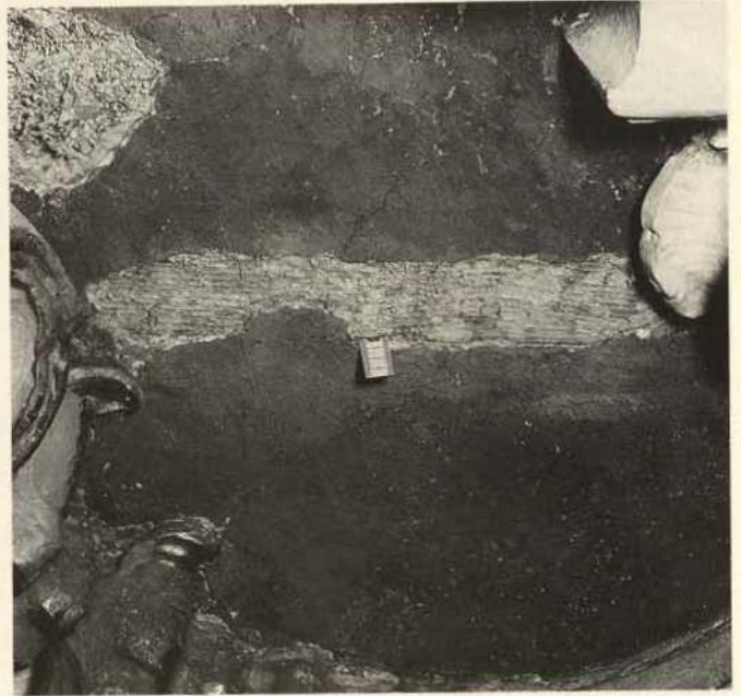
Abb. 18. Ausbruchstellen im Freskoputz, sichtbar die beigemengten Kälberhaare im Unterputz (arriccio) (siehe auch Abb. 1, S. 292)
