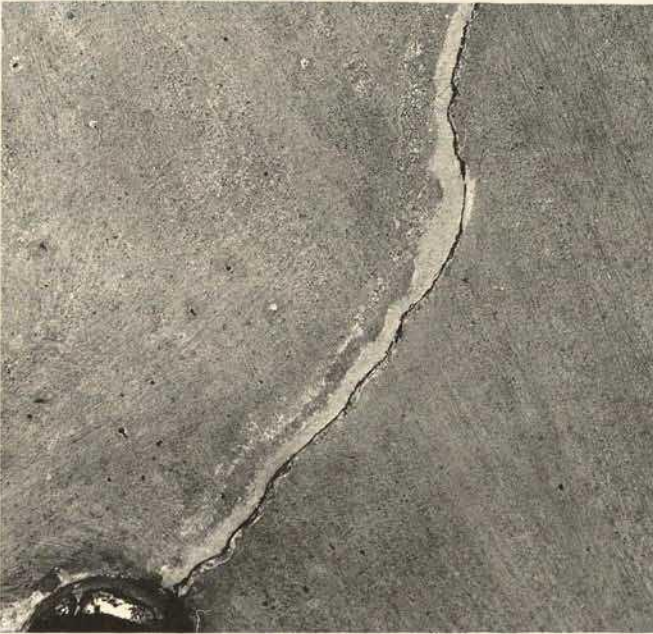
Abb. 29. Zentralraum; statisch bedingter Riß mit einseitig angekitteter Bruchkante
