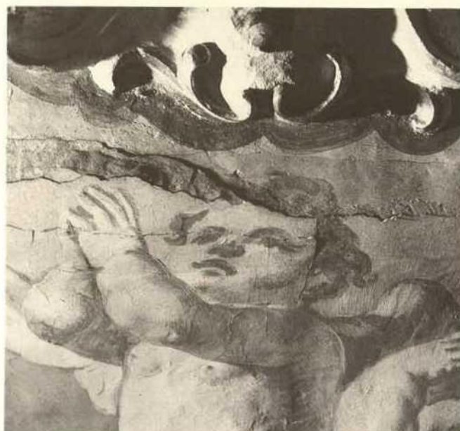
Abb. 26–28. Verschiedenartige Risse im Bereich des großen Kuppelfreskos und der acht Seligkeiten (Abb. 28)
