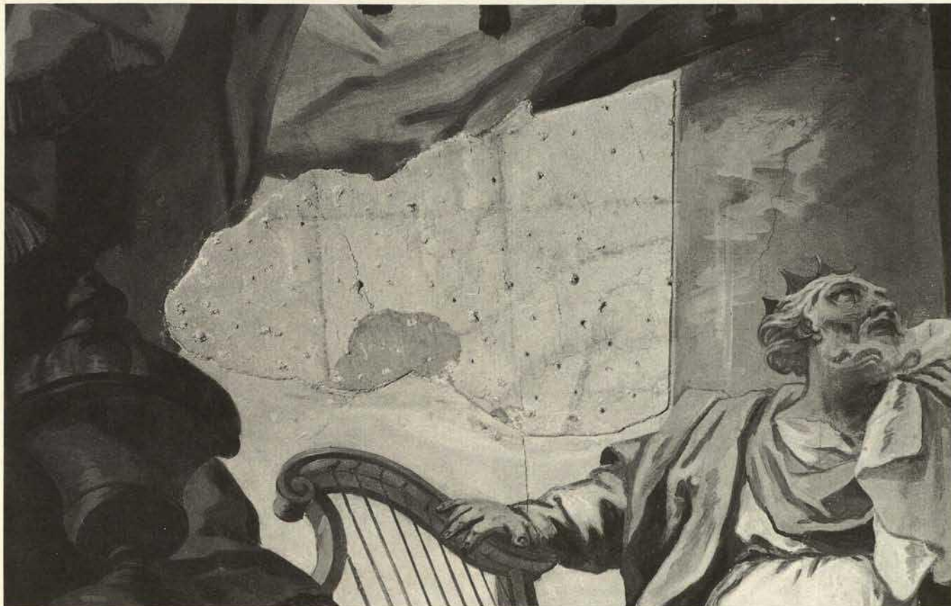
Abb. 19. «Nathan vor David» (Ausschnitt) über Orgelempore, nach teilweiser Abnahme von Putzausbesserungen; innerhalb der Fehlstelle schwarze Quadratur und rotbraune Pinselvorzeichnung zu sehen
