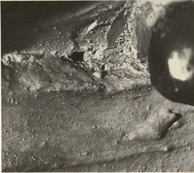
Abb. 20. Nagelloch eines vierkantigen Nagelschaftes, vgl. Farbtafel XXIV.4
