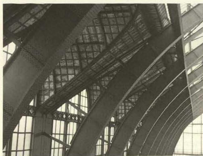
Abb. 2. Antwerpener Hauptbahnhof, Gleishalle, letztes Beispiel in Belgien einer monumentalen Gleishalle mit Dreigelenkbogenkonstruktion
