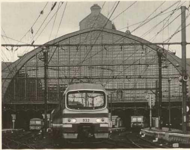
Abb. 5. Antwerpener Hauptbahnhof, Blick auf die Gleishalle nach der Restaurierung
