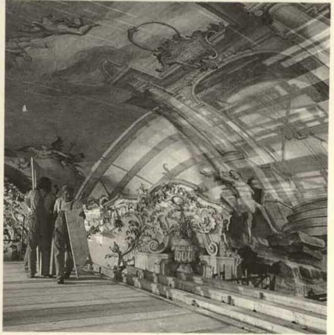
Gewölbereich, während der Restaurierung 1990 / Vault during restoration in 1990
