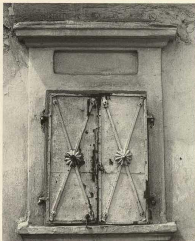
Abb. 34. Hauptstraße 152, „Zollnerhof“, Haustür der zweiten Wohneinheit mit korbboogenförmiger Laibung um das hinter dem Mauerwerk versetzte steinerne Türgewände, aufgedoppeltes Türblatt (Fenster nachträglich eingeschnitten).
