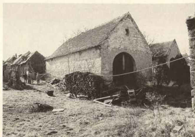
43. kép. Fő utca 152., „Zollner-ház“, a nyugati pajta északnyugatról, szabályos mészkő idomokból és terméskőből vegyesen falazva (eredetileg vakolt).
