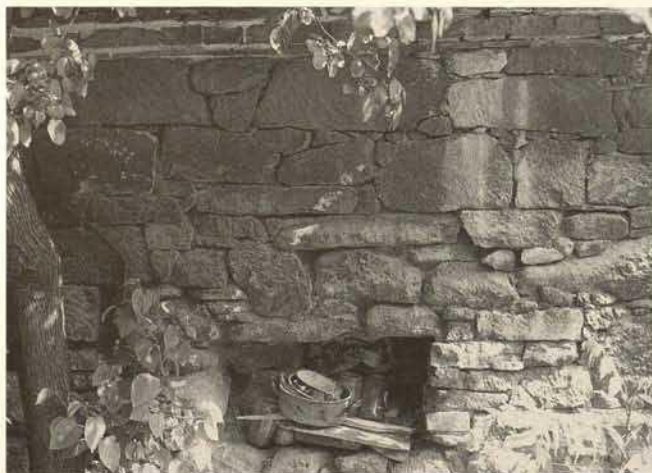
Abb. 46. Hauptstraße 152, „Zollnerhof“, rückwärtige (nördliche) Traufseite im Bereich der Stallungen, Detail des Mauerwerks mit durch das Flacheisen bearbeiteten Steinoberflächen.
