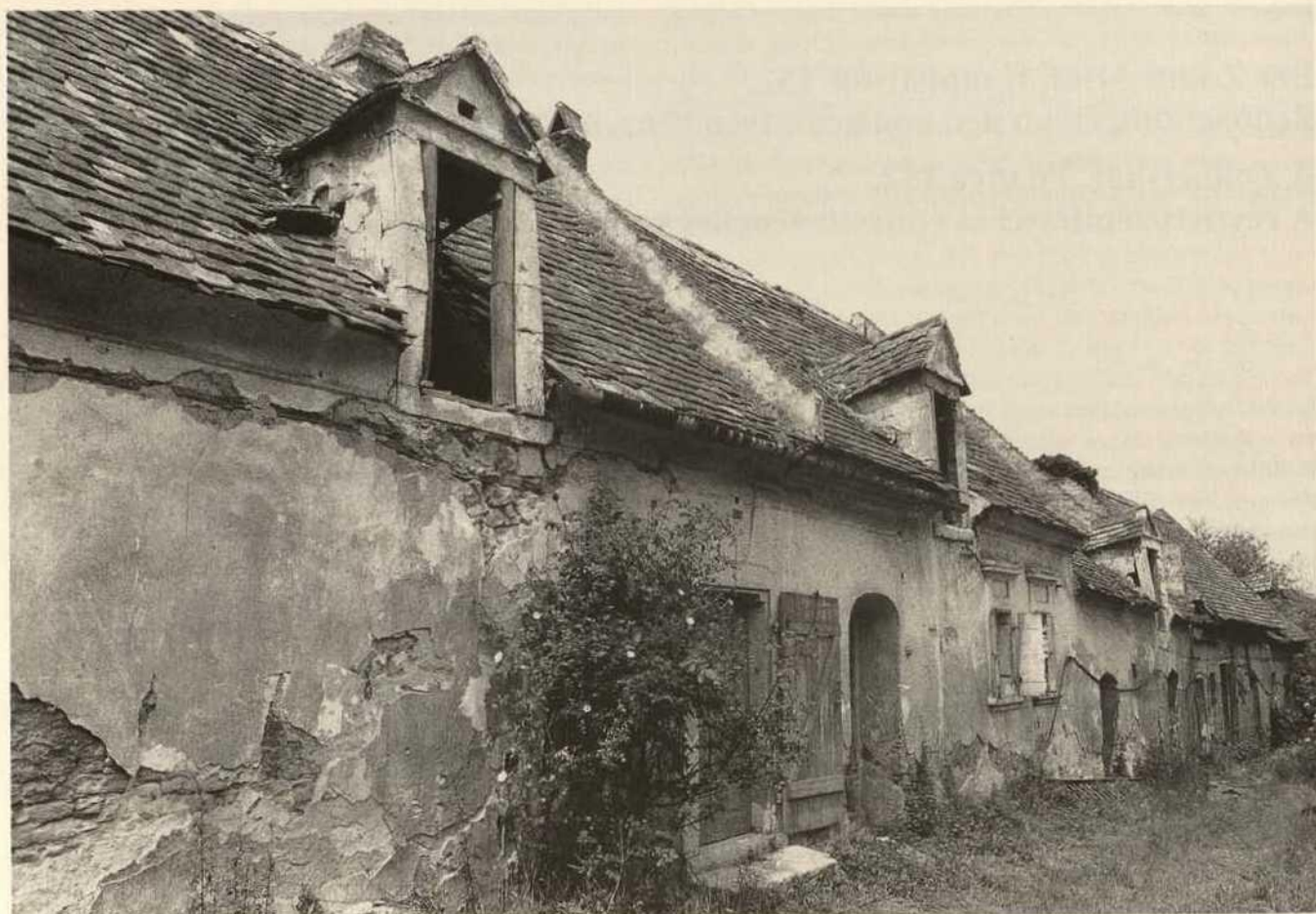
Abb. 26. Hauptstraße 152, „Zollnerhof“, südliche Hofansicht nach Osten.
