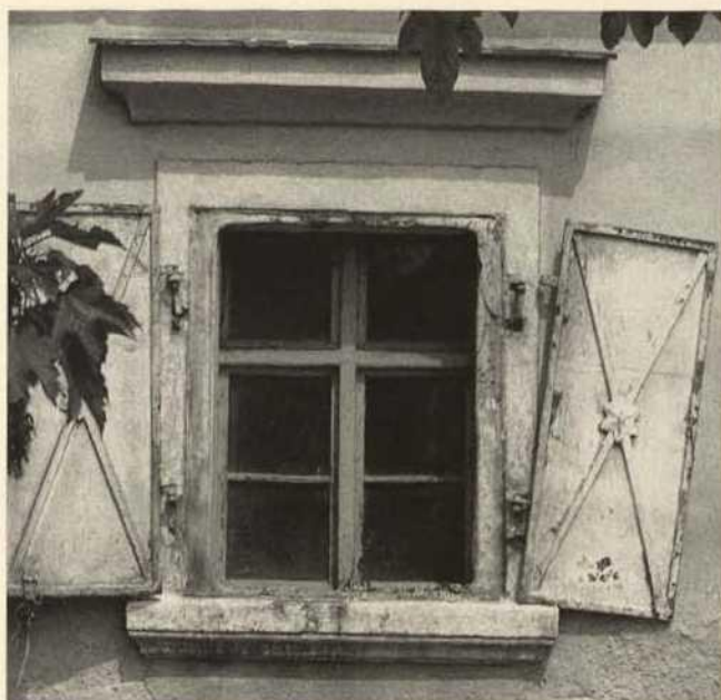
Abb. 31. Hauptstraße 152, „Zollnerhof“, Fenster der Westfassade mit eisernen Klappläden.
