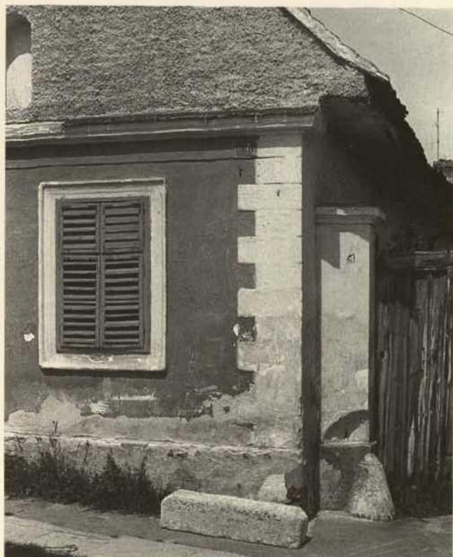
Abb. 100. Hauptstraße 60, Giebelfassade, Details der aufgetupften Gliederung mit profilierten Fensterfaschen und verzahnter Eckquaderung.
