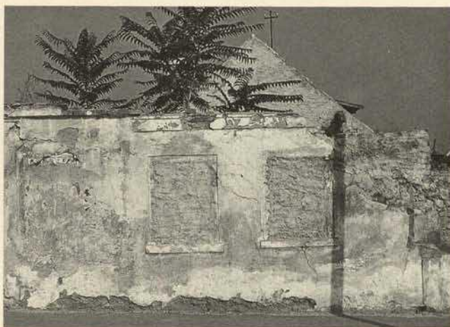
Abb. 134. Hauptstraße, teilweise abgebrochene Giebelfassade mit vermauerten Fensteröffnungen.
