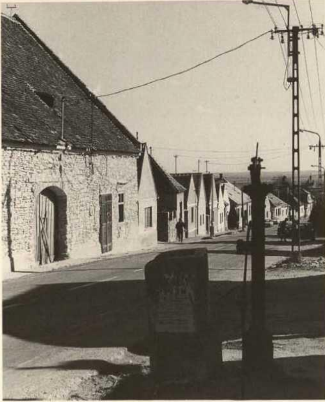
Abb. 94. Hauptstraße (Ostseite), vom ehemaligen Gasthaus (Nr. 172; vorne links) nach Süden.
