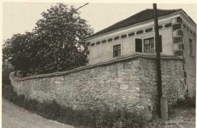
Abb. 112. Ehem. Mühle, Mühlengebäude mit der im Rahmen einer Umnutzung der siebziger Jahre wiederhergestellten Fassadenfassung (heute Ferienheim).
