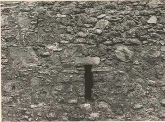
Abb. 114. Südliche Stadtmauer, westlicher Bereich, Detail mit Schießcharte.
