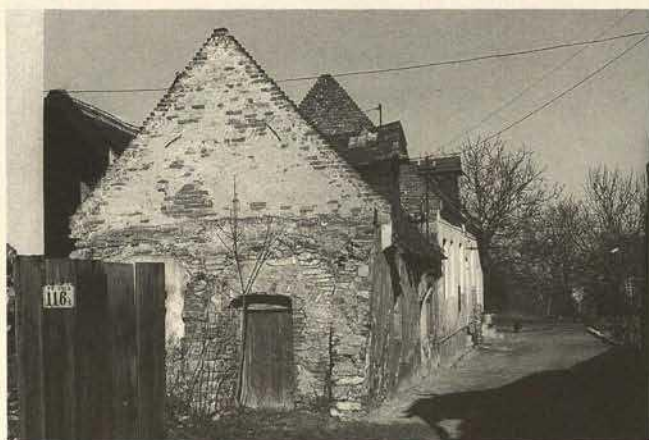
Abb. 132. Hauptstraße 116, Teilabbruch der historischen Hauszeile, Verlust der ältesten straßenseitigen Wohneinheit.
