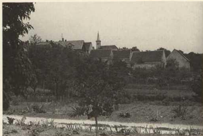
Abb. 85. Ortsrand im Südwesten, Scheunengürtel an der Hangkante der Grundstücke: rechts eine jüngere, die traditionelle Längsrichtung der Dächer aufgebende Scheune.
