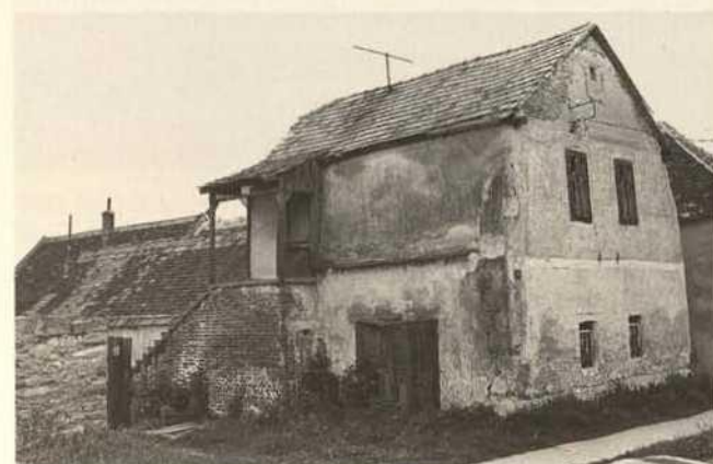
Abb. 103. Hauptstraße 118., alte Schmiede (sog. Zechmeisterhaus), zweigeschossiger Kalksteinquaderbau mit (wohl jüngeren) Giebeln aus Ziegelmauerwerk, Außentreppe und einfacher glatter Gliederung des rauhen Fassadenputzes.
