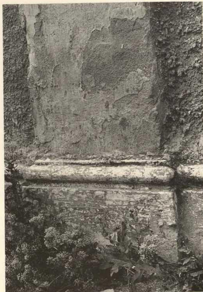
Abb. 124. Hauptstraße 60, barocke Hofanlage, Detail: aufgeputzter Pilaster der Hofmauer.
