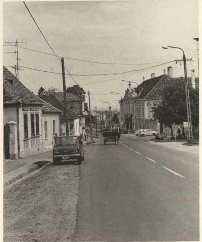
Abb. 96. Hauptstraße (unterer Bereich) nach Süden, rechts das Bischöfliche Palais.
