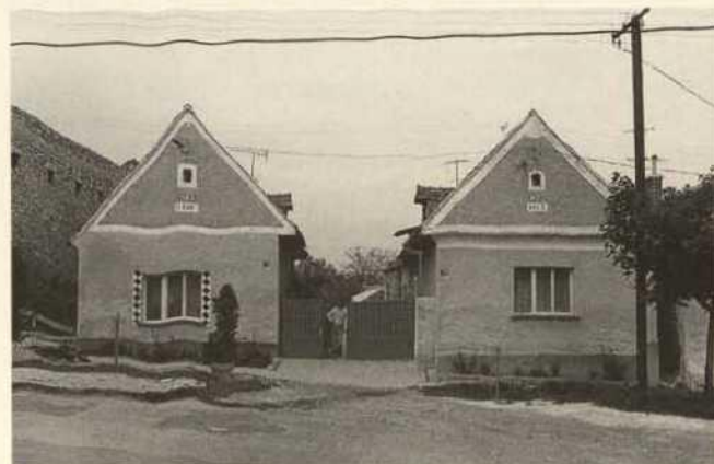
Abb. 106. Hauptstraße 88-90, Zweizeileranlage, jeweils mit hofseitiger Gred (vorkragendem Dach) und Datierung in der einfachen aufgeputzten Gliederung der Giebfelder (Initialen „G * PT“ und Jahreszahl „1863“ bzw. „1869“).
