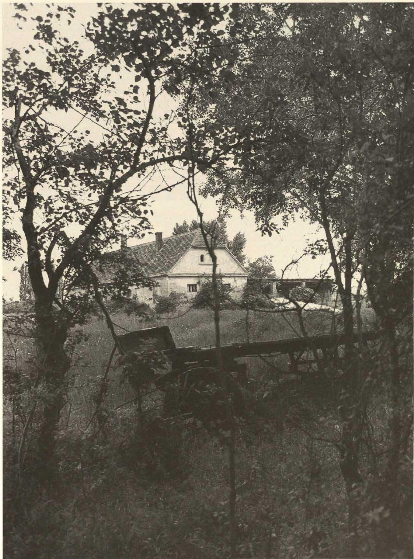
Abb. 143. Ehem. Sumpfbiet zwischen Fertörákos und dem Neusiedler See, Wirtschaftsgebäude einer Hofanlage neben der Kapelle, Südfassade, im Giebel bezeichnet 1872.
