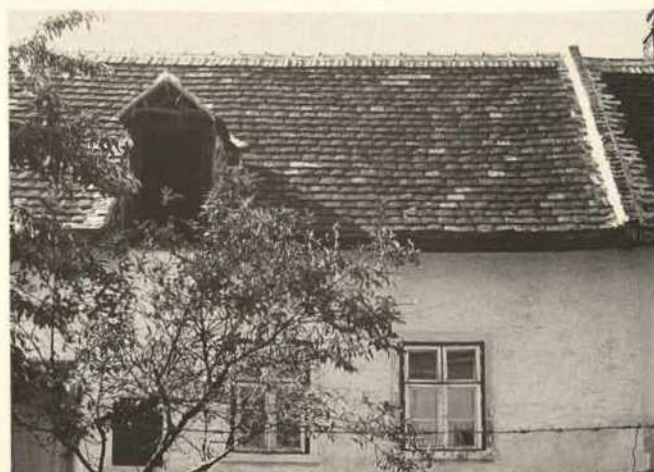
Abb. 125. Hauptstraße, charakteristische Dachdetails: handgeformte Dachziegel mit Vergrätungen an First und Ortgang.
