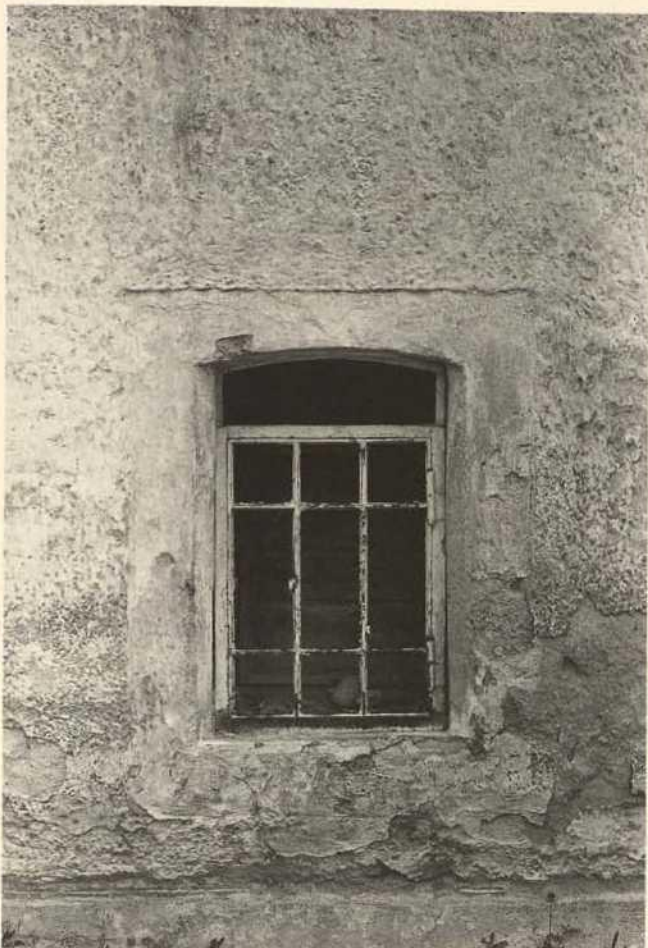
Abb. 126. Hauptstraße 118, alte Schmiede (sog. Zechmeisterhaus), Erdgeschoßfenster mit eisernem Rahmen und mittigem Lüftungsflügel. 126. kép. Fő utca 118., régi kovácsműhely (az un. Zechmeister-ház), földszinti ablak vas kerettel, középső szellőzőszárnnyal.
