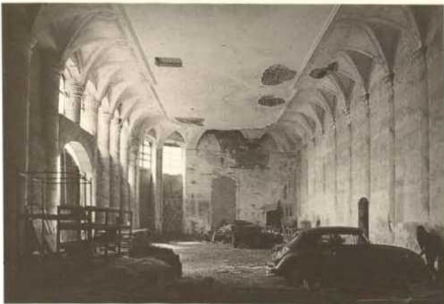
Abb. 7 und 8. Schloß Seehof, östliche Orangerie, links vor, rechts nach der Restaurierung
