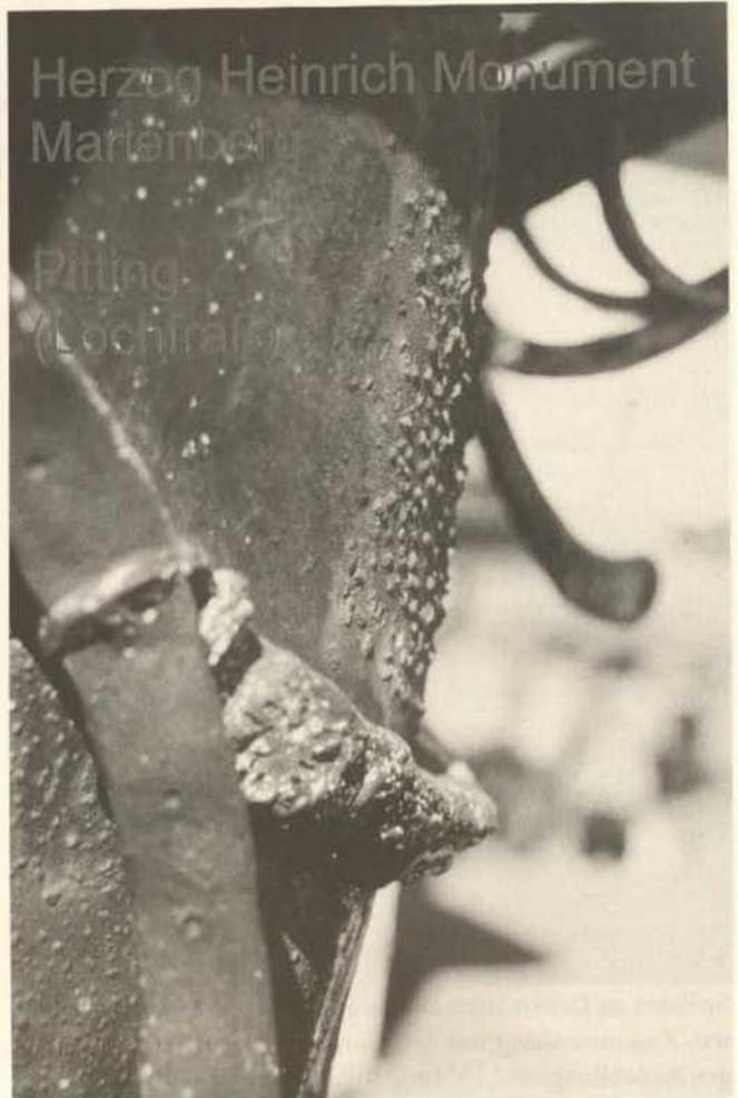
Abb. 1. Marienberg, Detail vom Herzog-Heinrich-Monument: Extreme Korrosionsschäden (Lochfraß)
