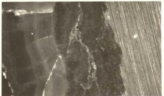
Abb. 5. Pfarrkirche Aldersbach, Chorgestühl, Zinnornament (18. Jh.); Querschliff, korrosive Umwandlung des Metalls bis über die Hälfte der Materialdicke zu Zinnoxiden; im Bild ist die gesamte Dicke des Ornaments dargestellt; Bildhöhe = 0,56 mm
