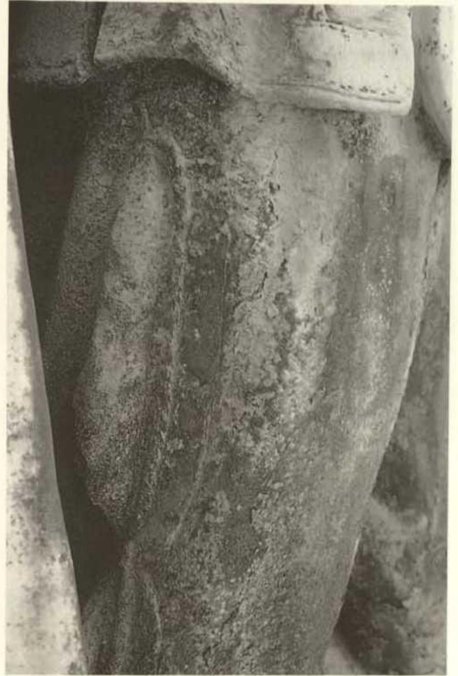
Abb. 7. Fürst-Ludwig-Statue, Schadensbild am Beinkleid, vor der Restaurierung, 1994
