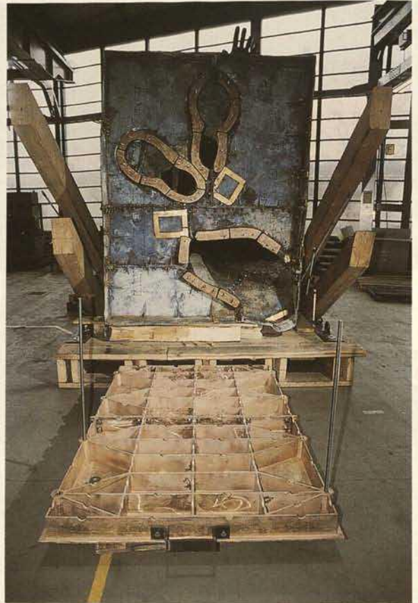
2. Berlin-Tiergarten, „Rotarmist“; Stabilisierungsmaßnahmen in der Plinthe des „Rotarmisten“, im Vordergrund die neue bronzenne Unterkonstruktion für die statisch sichere Wiederaufstellung des Denkmals
