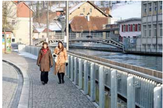
Abb. 4: Schutzwand gegen das Eintreten eines Hochwassers in das Mattequartier, 2005 kurzfristig errichtet
