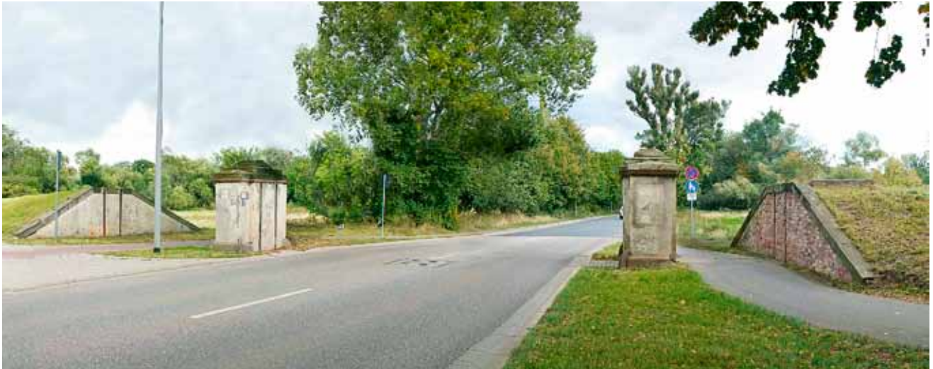
Abb. 2: Ausgangszustand der Deichscharte Wasserstadt, Dessau-Roßlau
