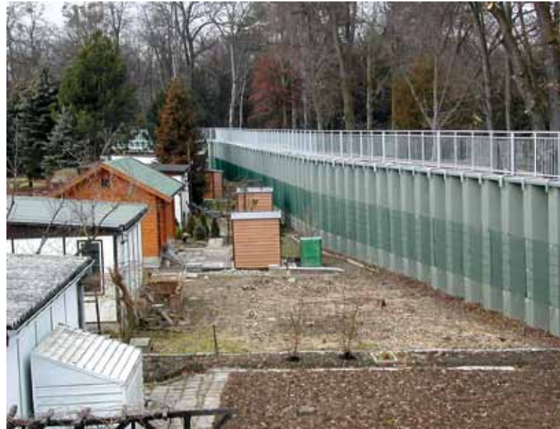
Abb. 5: Spundwandkonstruktion am Park Luisium, südlicher Ringdeich von der Landseite aus gesehen
