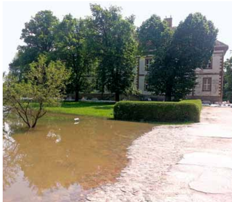
Abb. 1: Schloss Kühnau beim Hochwasser im Juni 2013, operativer Hochwasserschutz am Gebäude zur Verhinderung des Einströmens von Wasser
