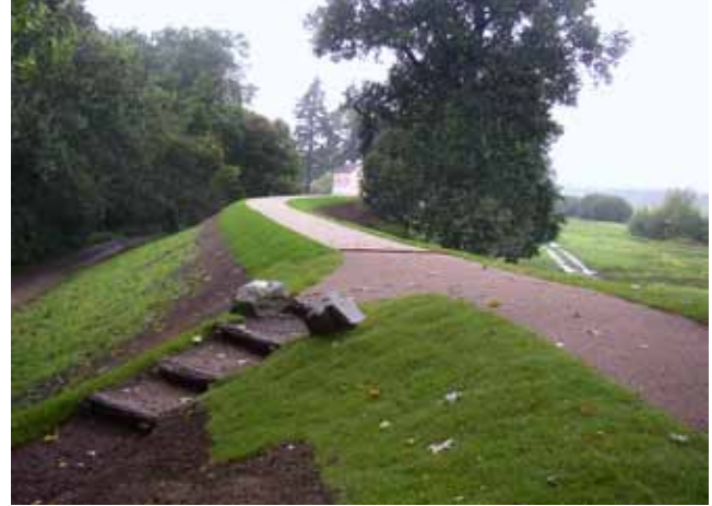
Abb. 8: Deich Park Wörlitz nach Abschluss der Sanierungsmaßnahmen
