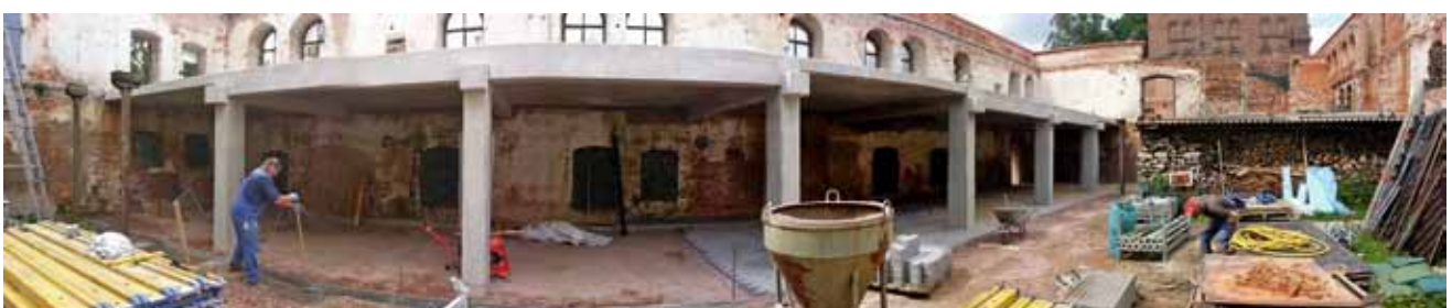
Abb. 4: Jonitzer Mühle, fertiggestellte Stützkonstruktion der wasserseitigen Ruinenwand durch Stahlbetonkonstruktion mit Deckenscheibe
