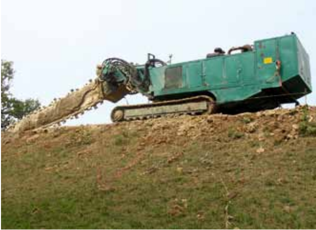
Abb. 7: Fräse zur Herstellung der FMI Wand als Dichtungswand im Deich Wörlitz
