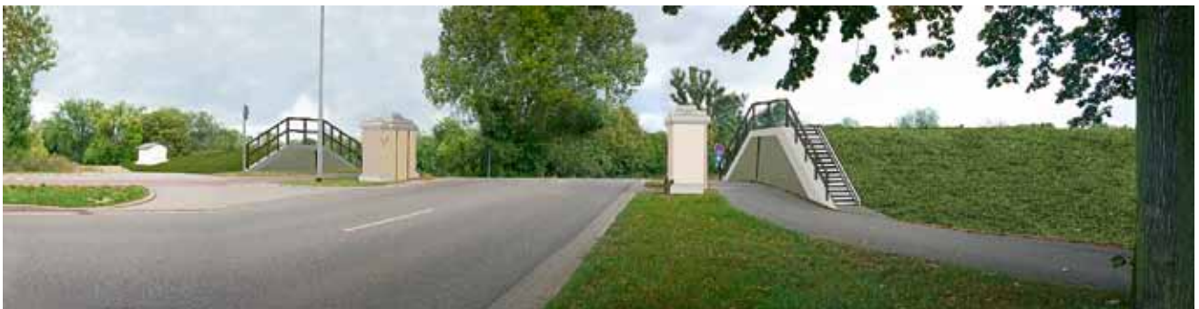
Abb. 3: Simulation erhöhter Deich mit Anhebung der Fahrbahn im Bereich der Deichscharte Wasserstadt, Dessau-Roßlau
