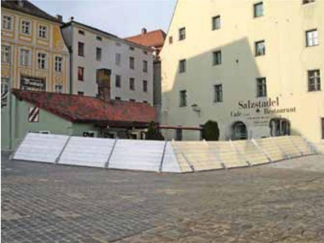
Abb. 8a: Katastrophenschutzelemente am Salzstadel im Übungsfall
