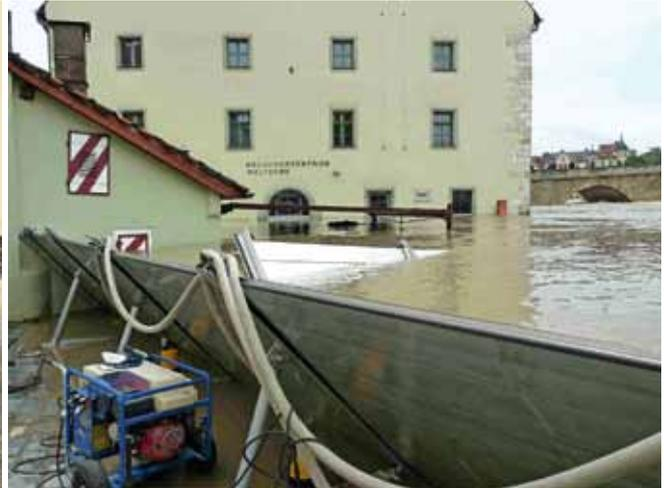
Abb. 8b: überflutete Katastrophenschutzelemente am Salzstadel beim Hochwasser im Juni 2013 (links die Wurstkuchl)
