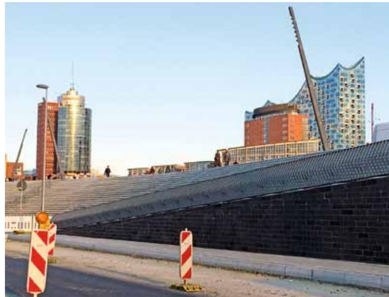
Abb. 8: Hamburg, Promenade im Bereich der U-Bahnstationen Baumwall und Landungsbrücken, Flutschutzmauer mit Treppenanlagen, Zaha Hadid Architects, im Bau (2015)
