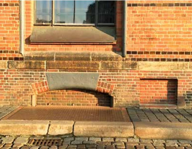
Abb. 2: Hamburg, Speicherstadt (ab 1883), zugesetzte Fensteröffnungen im Erdgeschossbereich (2014)
