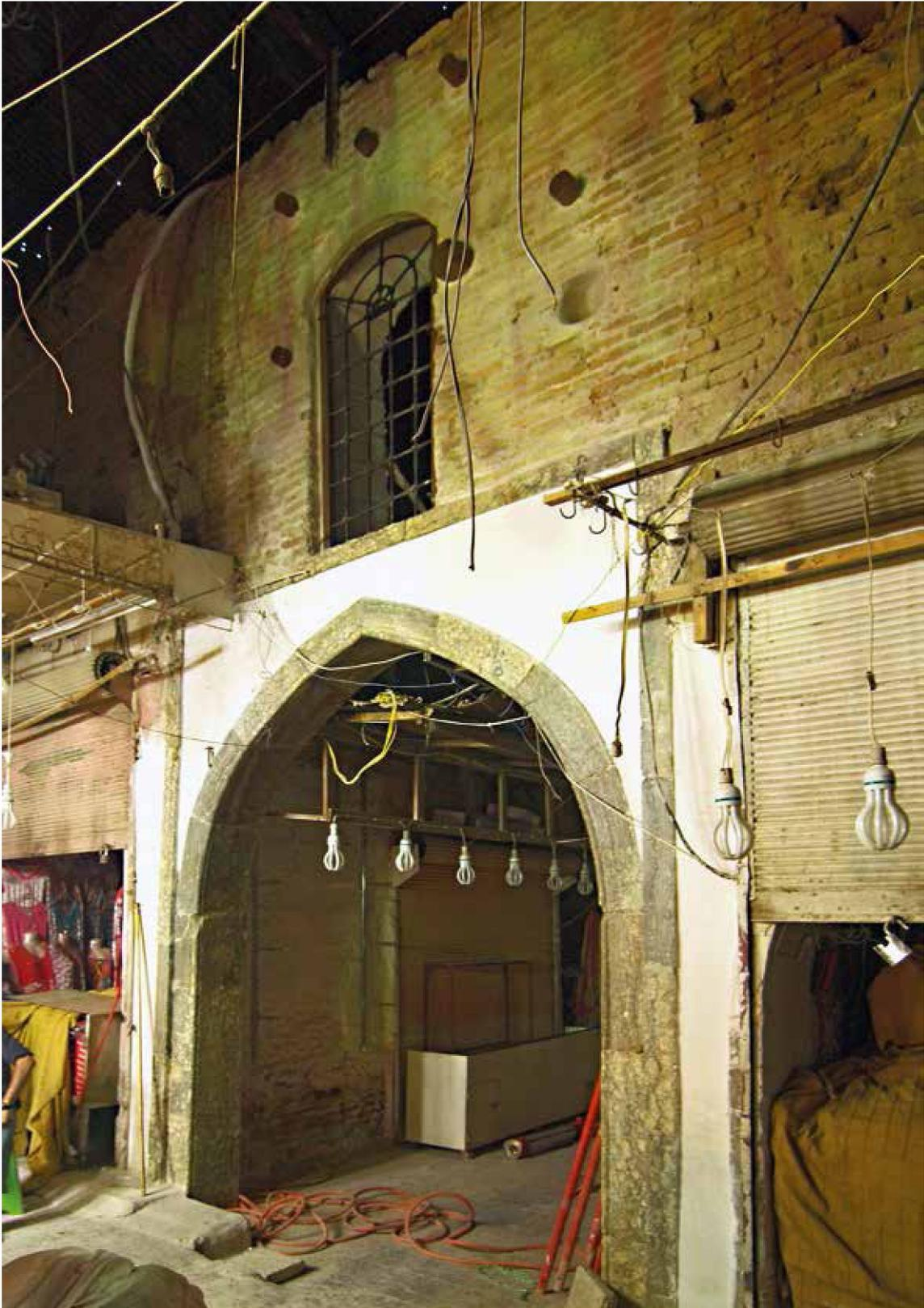
7 Erbil, Nord-Irak. Konservierte Fassaden-Musterflächen an der westlichen Qaisariya im Basar mit gereinigten und versiegelten Natursteinbauteilen, ergänzt um neu verputztes Ziegelmauerwerk sowie einem rekonstruierten schmiedeeisernen Fenstergitter im Obergeschoss. Foto: Dietmar Kurapkat, DAI Berlin.
