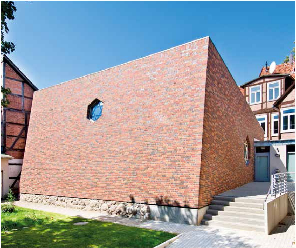
10 Schwerin, Synagoge, Ostfassade, mit historischen Fundamenten. Foto: Brenncke Architekten.
