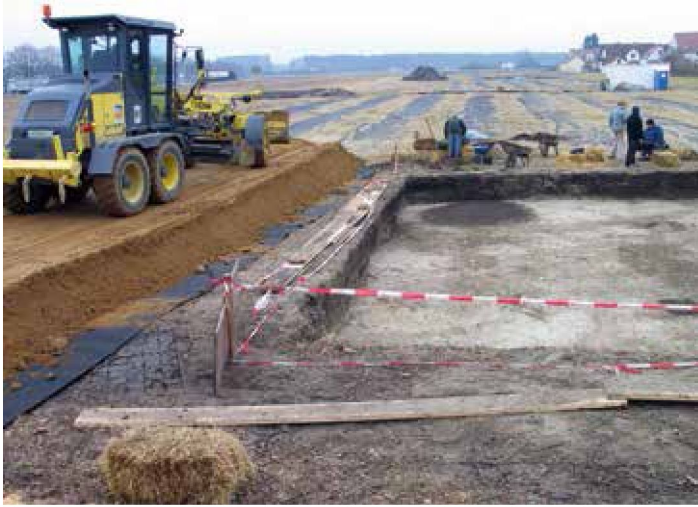
8 Keltisches Oppidum von Manching, Oberbayern; großflächige Überdeckung von Teilen des Bodendenkmals durch Geotextilien und Kies als Unterbau für mehrere Supermärkte. Bayerisches Landesamt für Denkmalpflege; Foto: E. Claßen.
