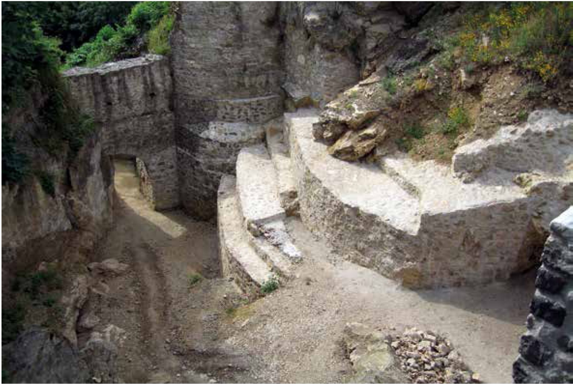
11 Der unkontrolliert ausgehobene Burggraben der Burg Wolfstein bei Neumarkt, Oberpfalz, musste zur Abstützung eines durch den fehlenden Schutt instabil gewordenen Burgteils mittels umfangreicher Stützbauwerke wieder teilweise „aufgefüllt“ werden. Bayerisches Landesamt für Denkmalpflege; Foto: C. S. Sommer.
