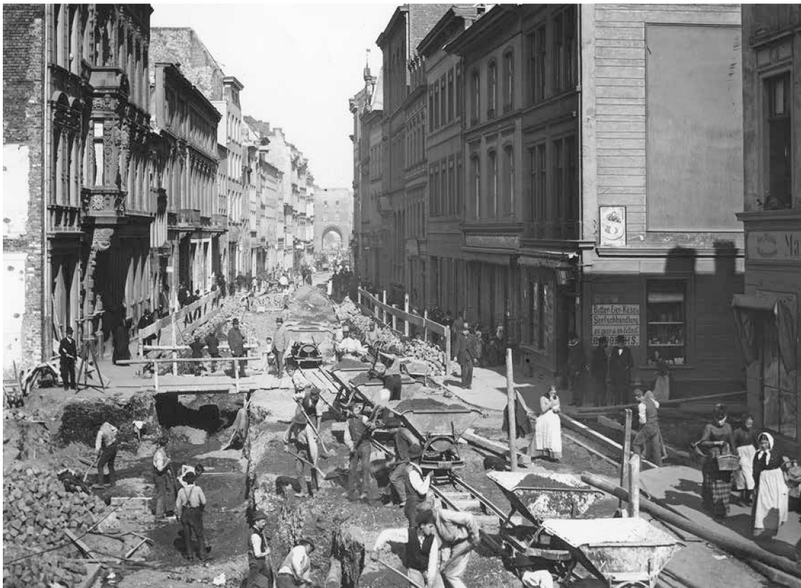
2 Kanalarbeiten auf dem Eigelstein um 1890, im Bildhintergrund die mittelalterliche Torburg. Rheinisches Bildarchiv Köln.
