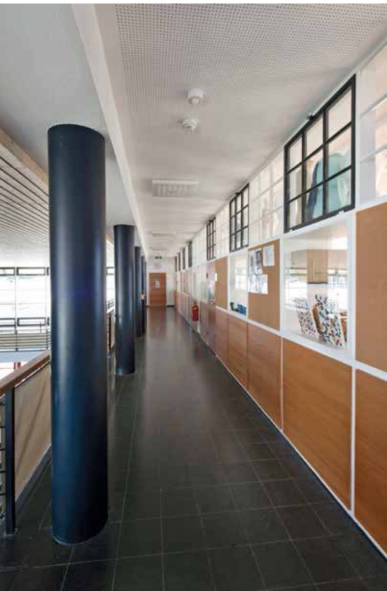
Abb. 8: Klassenwand zur Halle, die Decke mit Schallschutz
