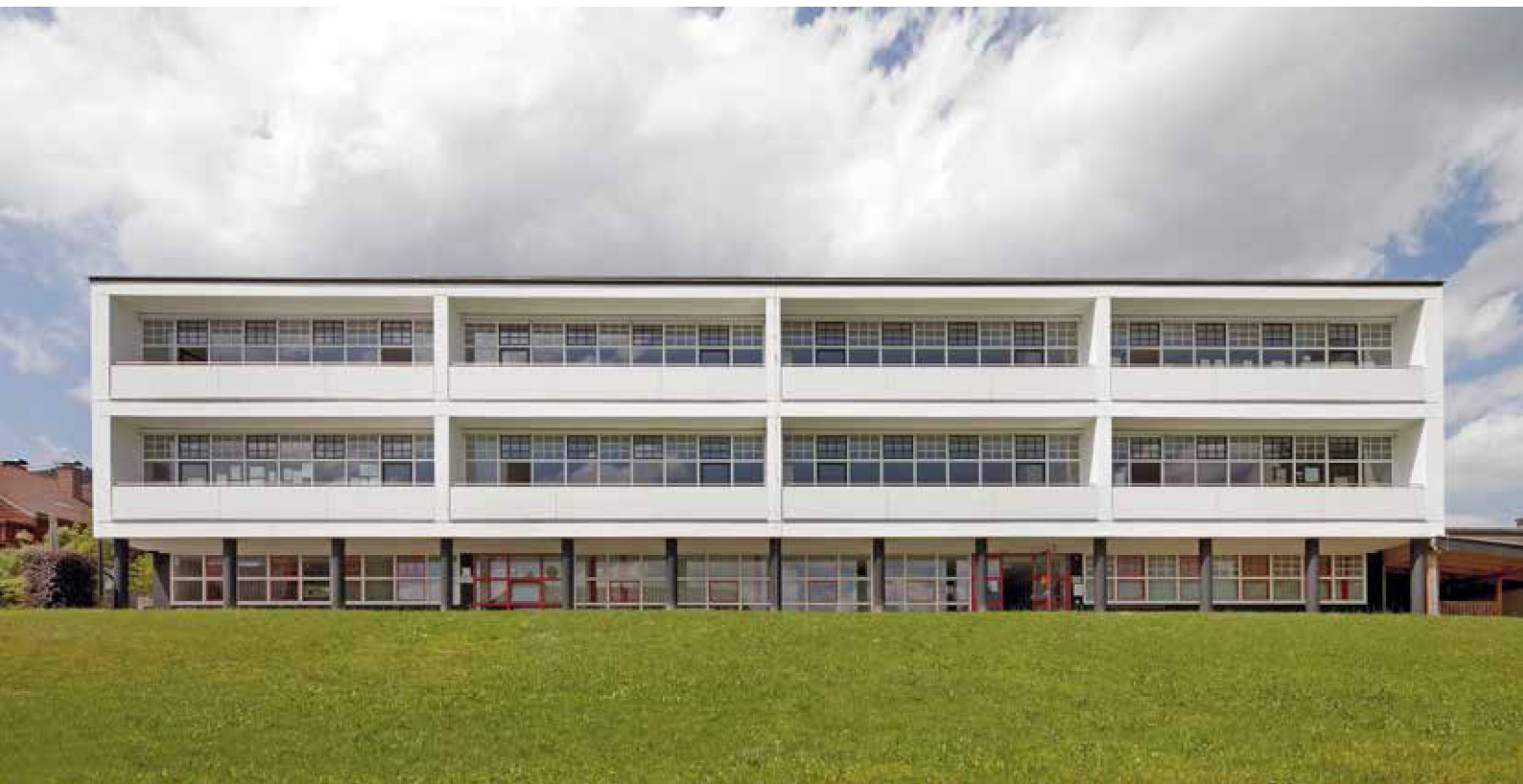
Abb. 1: Die Vorderfront der Schule nach der Restaurierung
