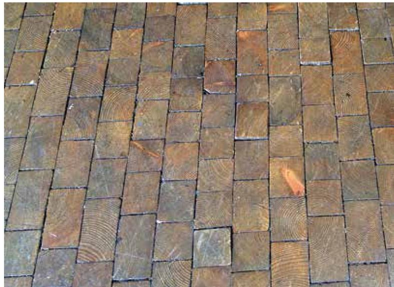
Abb. 12: Bodenbelag des Untergeschosses, Vorbestand
