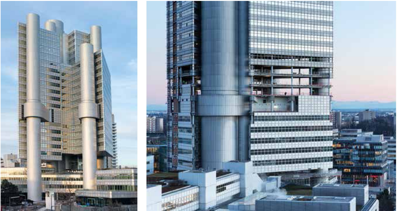
Abb. 11 und 12: München, HVB-Tower, ehem. Verwaltungshochhaus der HypoVereinsbank, Arabella-Park, 1970–81, Walter und Bea Betz, Sanierung 2015, Henn Architekten, München
