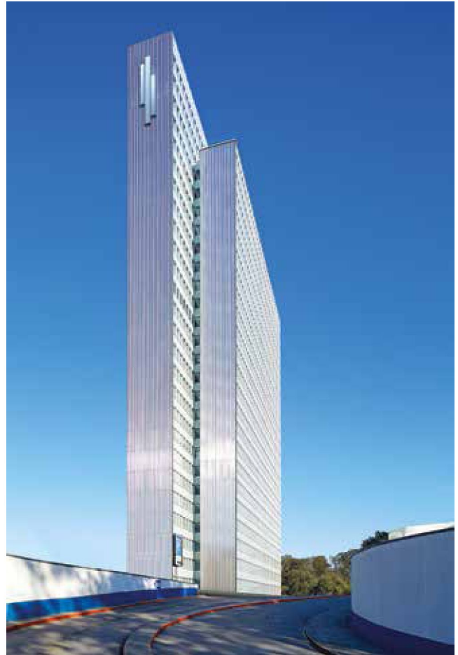
Abb. 10: Düsseldorf, Dreischeibenhochhaus, Helmut Hentrich und Hubert Petschnigg 1957–60, Südansicht, Sanierung 2012–15, HPP, Düsseldorf
