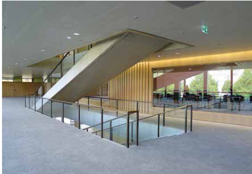
Abb. 7: Stuttgart, Landtag, Kurt Viertel, Horst Linde und Erwin Heinle, 1959–61, Sanierung 2013–2016, Staab Architekten, Berlin
