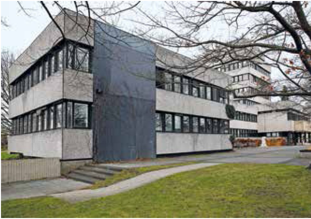
Abb. 8: Ahrensburg, Rathaus, Karl-Heinz Scheuermann, 1968–70, Sanierungsplanung 2015 ff., denkmalpflegerische Beratung iTUBS
