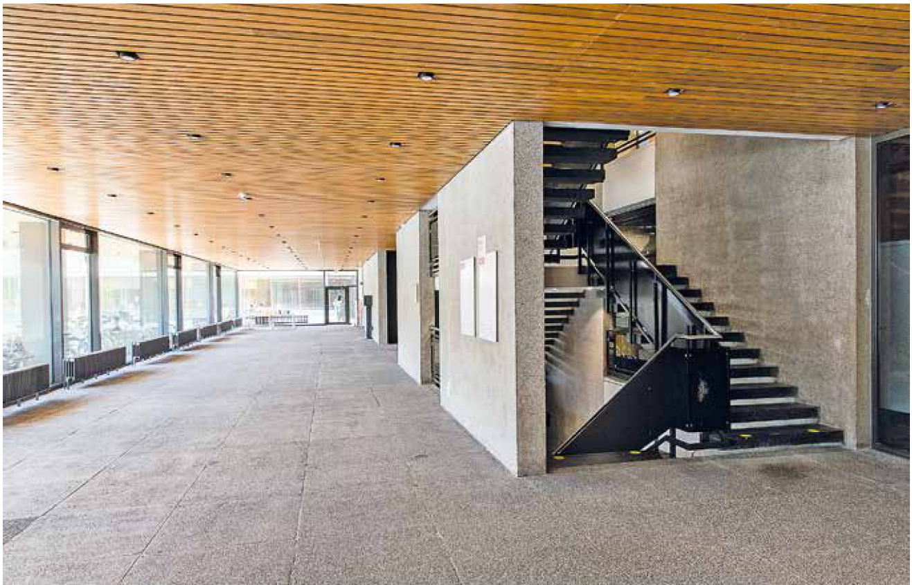
Abb. 9: Braunschweig, Forumsgebäude der Technischen Universität, Friedrich Wilhelm Kraemer. 1957–60. Foyer nach Sanierung 2012–2016
