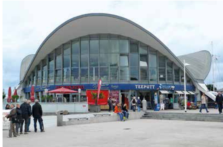
Abb. 2: Warnemünde, sog. Teepott, Ulrich Müther, 1967, Sanierung 2001–02, buttler architekten, Schwerin, Zustand 2011
