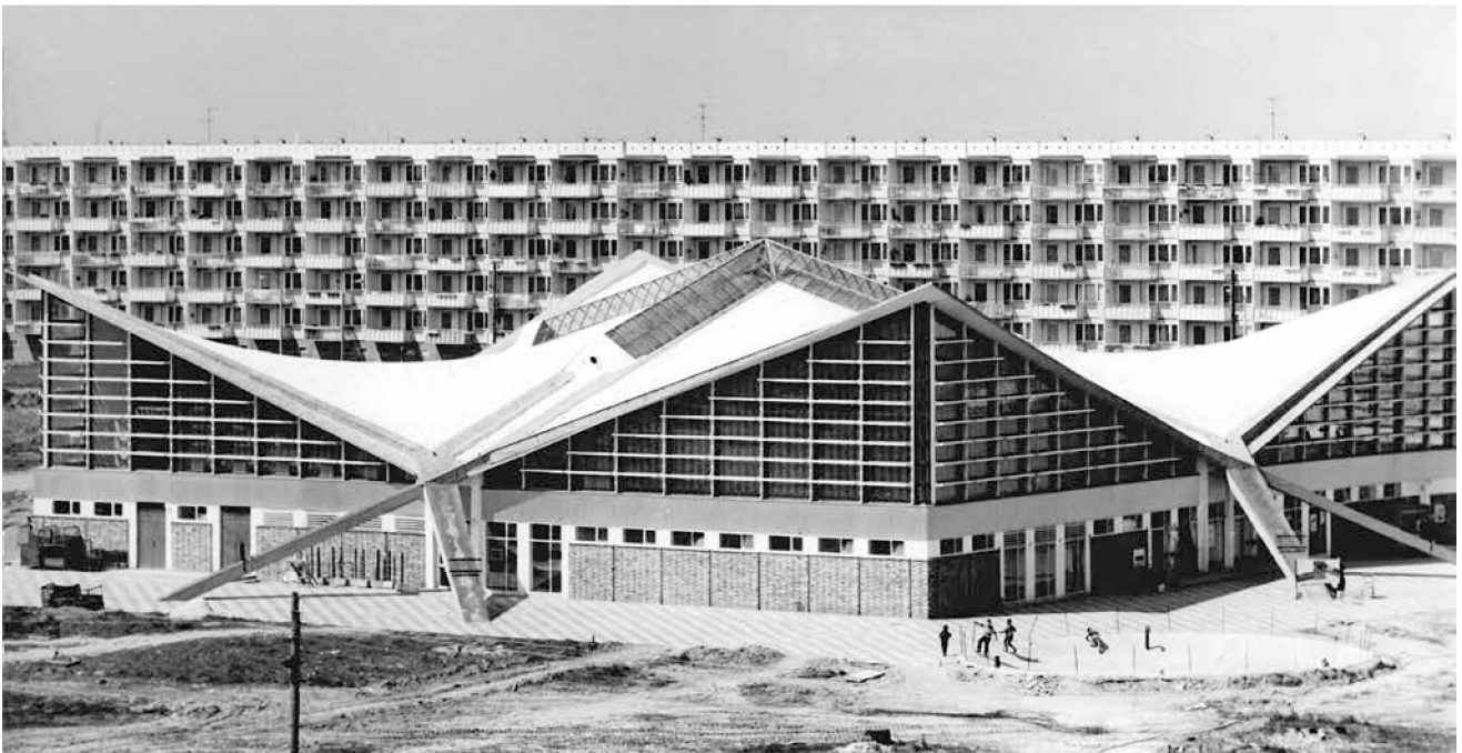
Abb. 1: Rostock, Lütten Klein, Mehrzweck-Kaufhalle, Ulrich Müther, 1966, Aufnahme 1969
