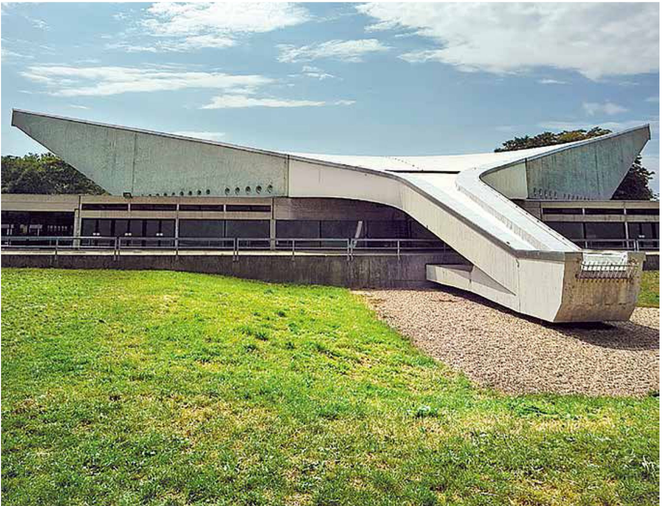
Abb. 1: Friedrich-Ebert-Halle in Ludwigshafen, Architekt Roland Rainer (Baujahr 1965)
