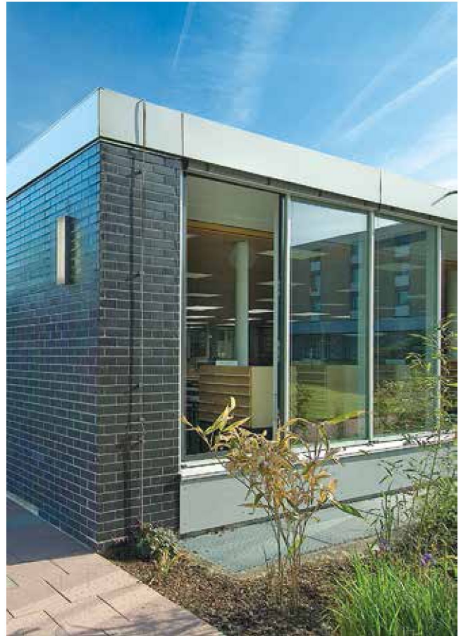
Abb. 2: Deutsche Universität für Verwaltungswissenschaften in Speyer, Architekt Sep Ruf (Baujahr 1960), Generalsanierung BOS Architekten aus Mainz
