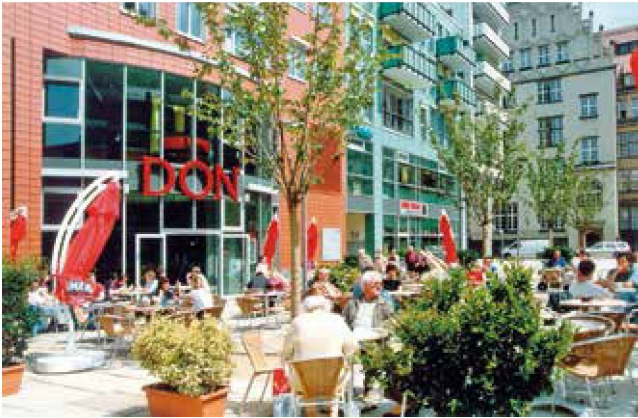
Abb. 8: Jakobikirchplatz, Neubau mit Gastronomie 2003
