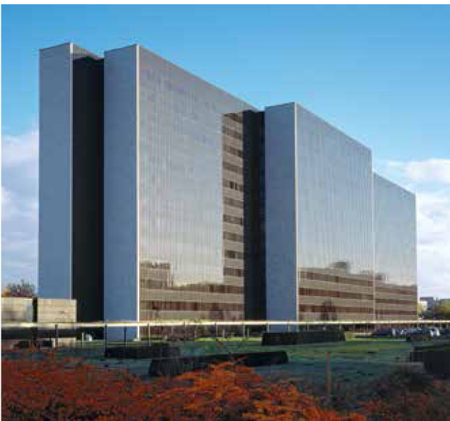
Abb. 5: Gebäude der Hamburgischen Electricitätswerke (heute: Vattenfall), Architekt Arne Jacobsen
