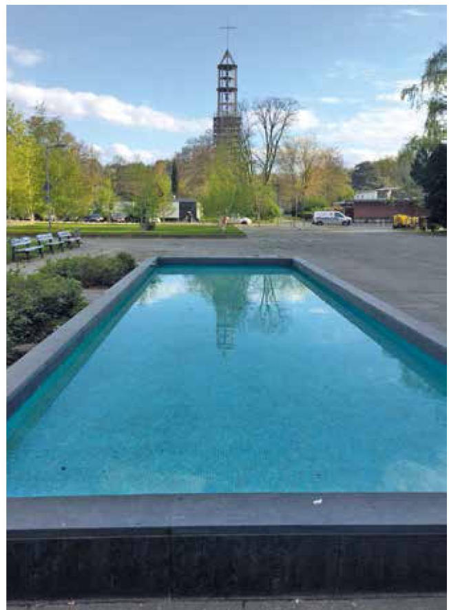
Abb. 10: Südlicher Hansaplatz: Wasserbecken und angrenzende Platzflächen nach denkmalgerechter Instandsetzung
